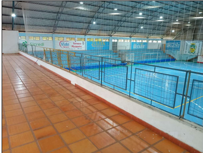
Figura 1 - Guarda-corpo a ser removido (exceto mureta).
