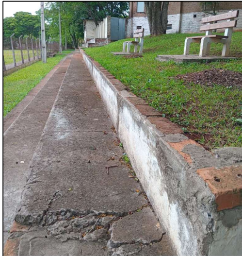
Figura 13 - Contenção que receberá o reforço estrutural.
