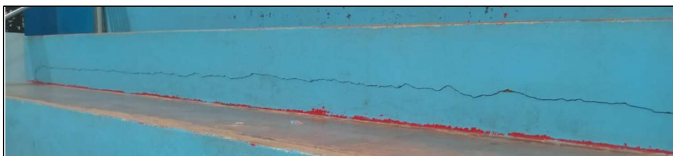
Figura 4 - Exemplar de vício aparente a ser reparado.
