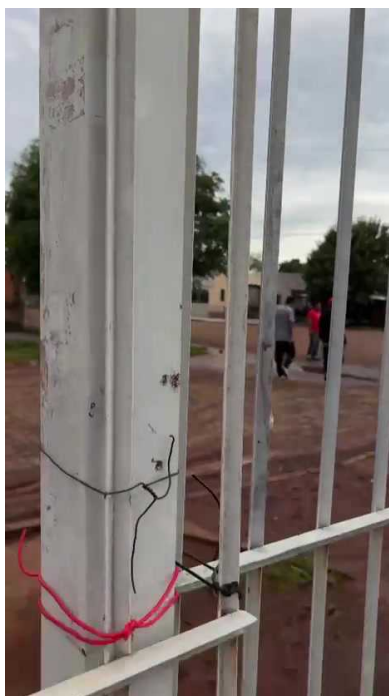
Foto 07 – Portão de acesso: coluna com fixação provisória por amarração (quadro de vídeo).
