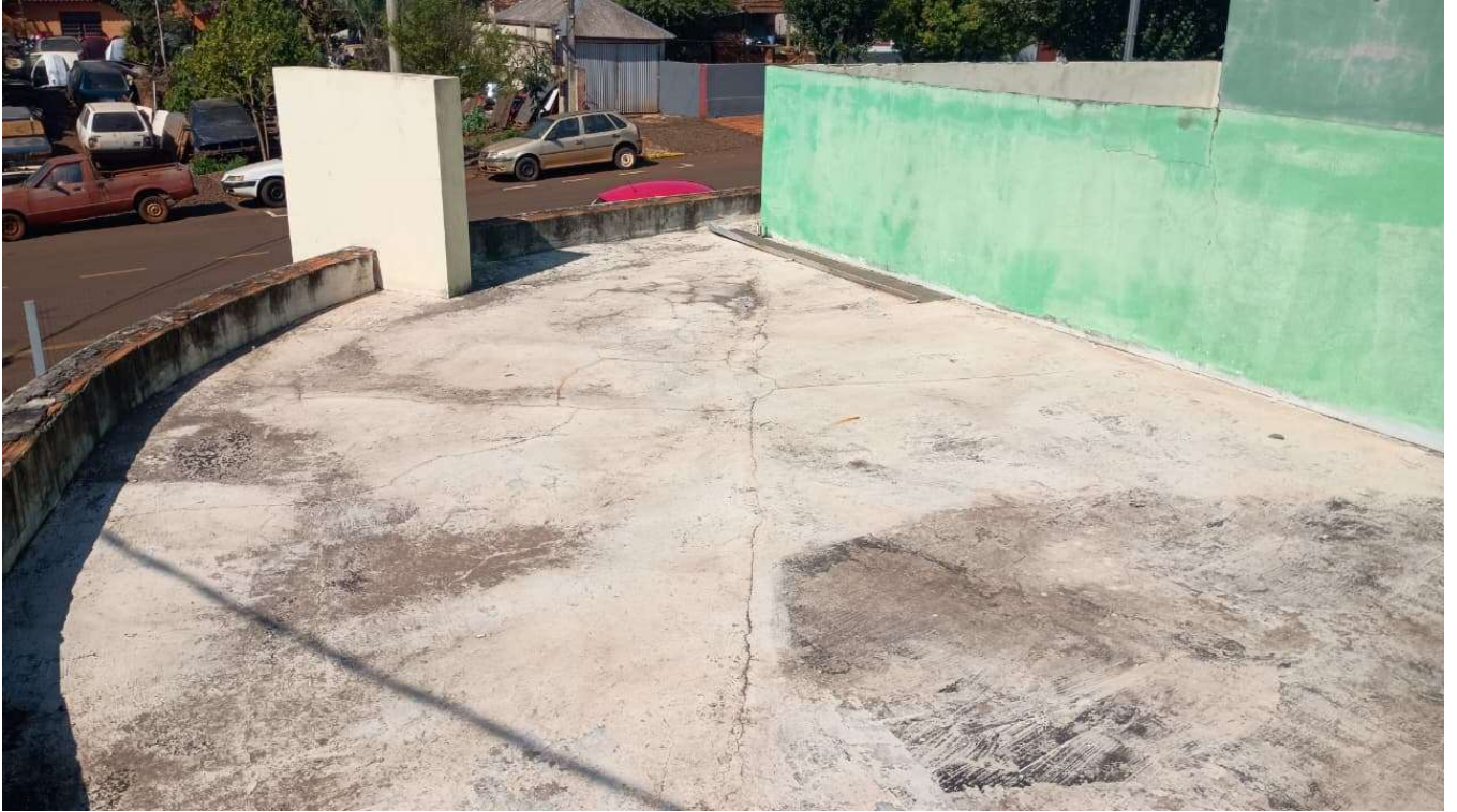
- Telhado a ser reformado.
