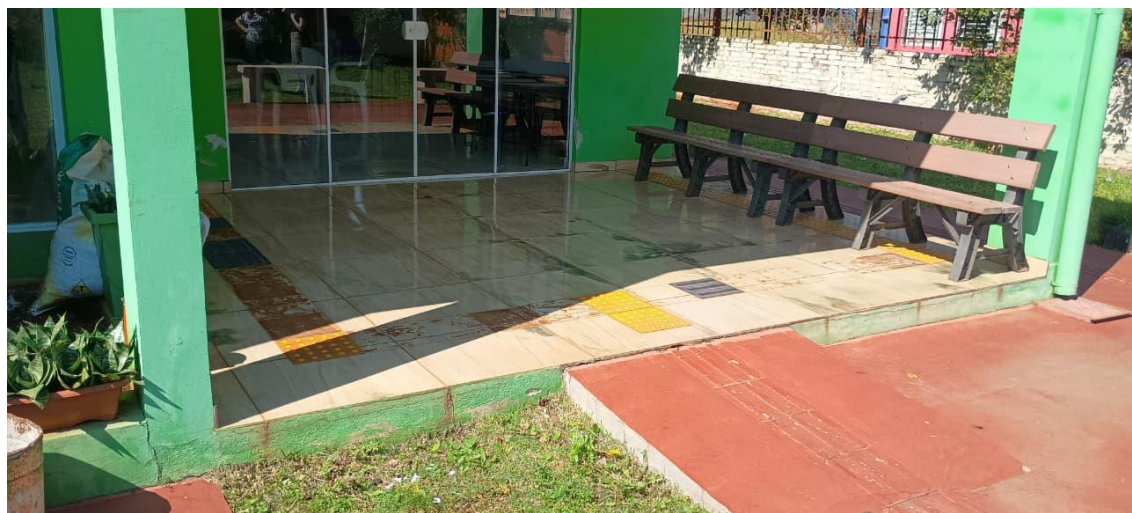
Legenda: Fotos do telhado e do local onde será reformado para sala de atendimento.
