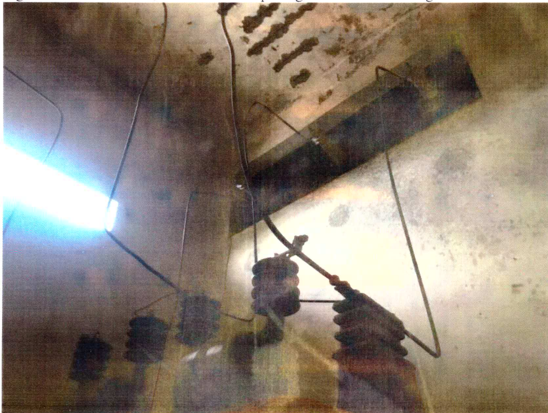
Figura 4. Vista dos TCs, TPs e bucha de passagem – Saída de Energia
