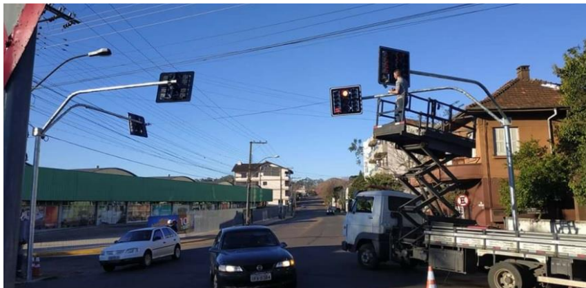
Equipe técnica especializada realizando uma implantação de solução semafórica.
