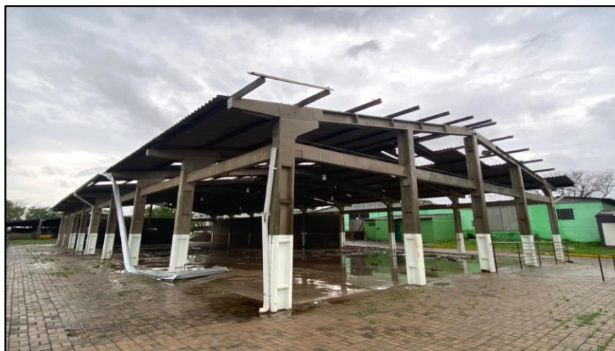
Imagem 1: Pavilhão AGRO, vista lateral.
