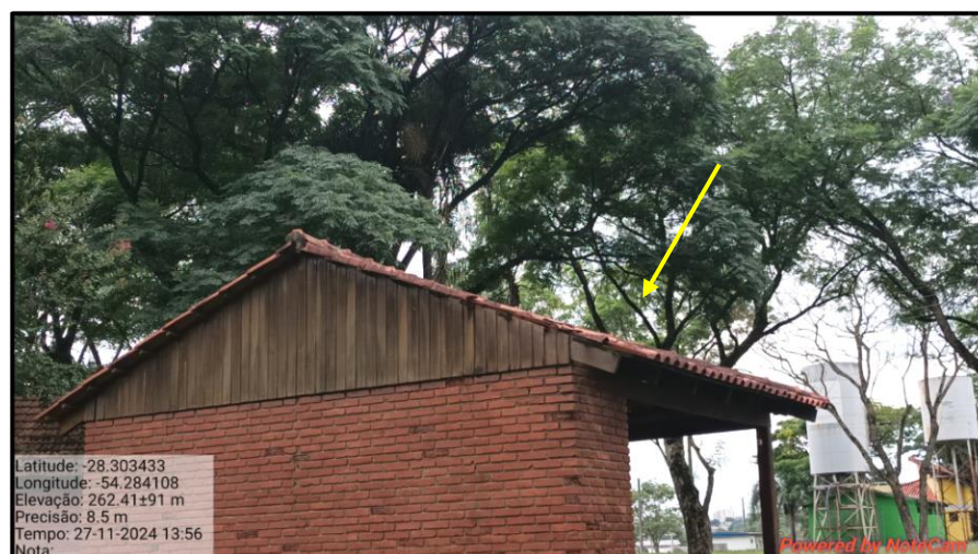
Imagem 8: Detalhe do banheiro e suas condições estruturais.
