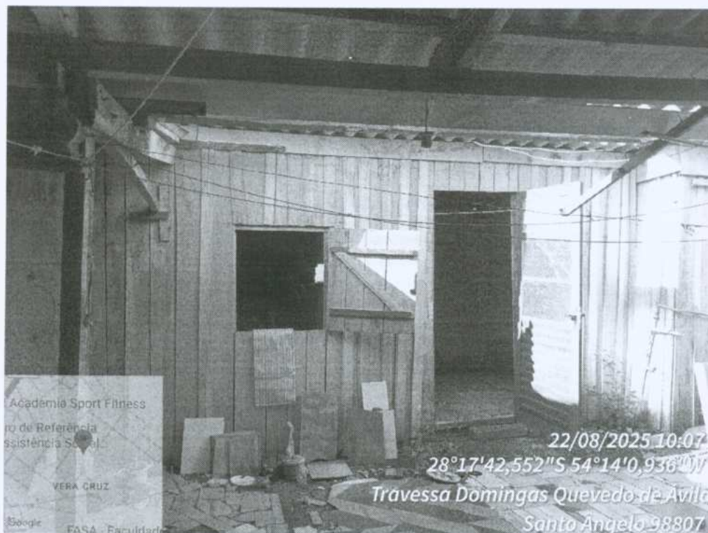
Foto 12: Galpão/depósito nos fundos.
