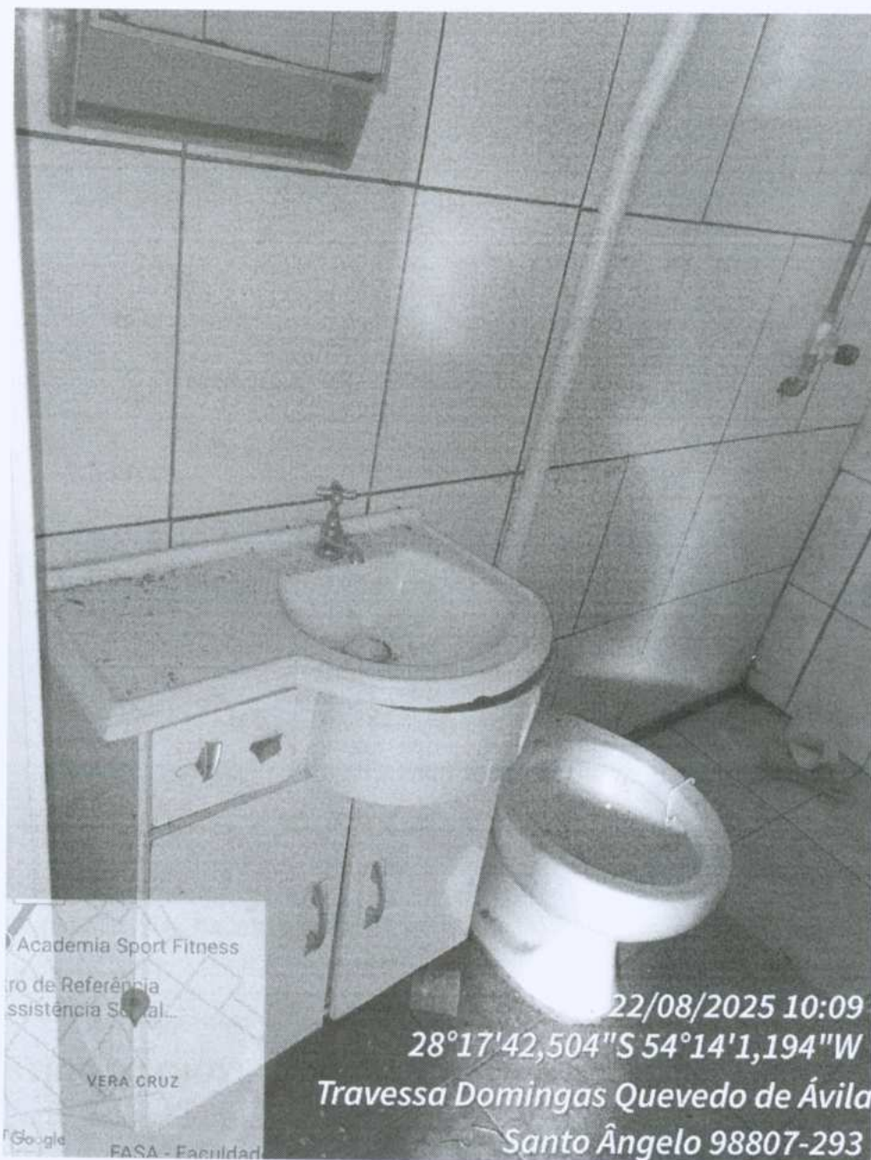
Foto 14: Banheiro do depósito/galpão.
