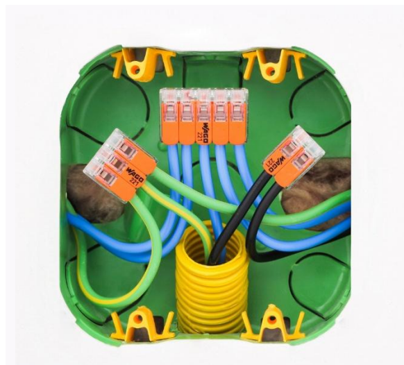
Figura 4. Exemplos de conexões com conectores tipo WAGO ou similares.
