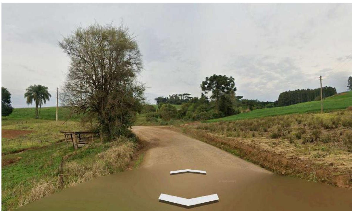
Figura 2 – Início do trecho - km 28+200,00 (Sentido Ida)
