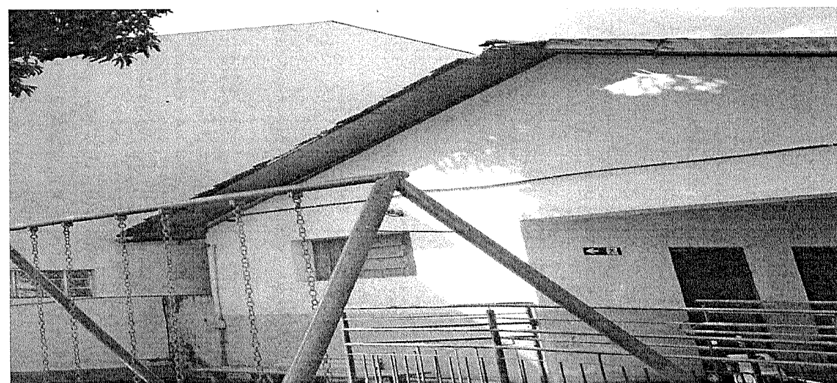
3-RECONSTRUÇÃO DE BEIRAL - ESPELHO - FORRO - FACHADA NORTE
