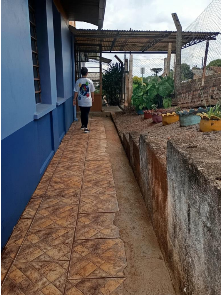
Figura 8 pisos e degraus e muros, em vários níveis
