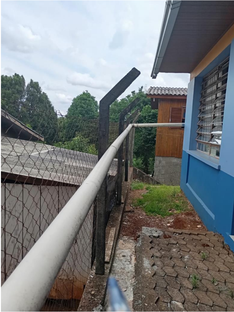
Figura 5 canalização pluvial que deve ser retirada
