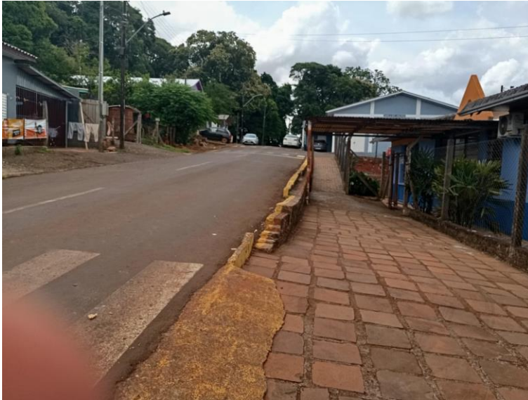
Figura 10 a rampa devesa ser mantida porém alargada conforme projeto
