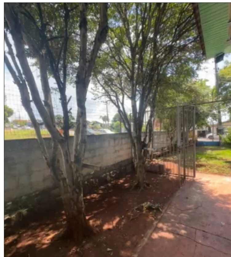
MURO LATERAL DIREITA
