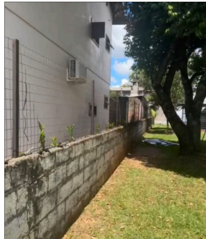
MURO LATERAL ESQUERDA
