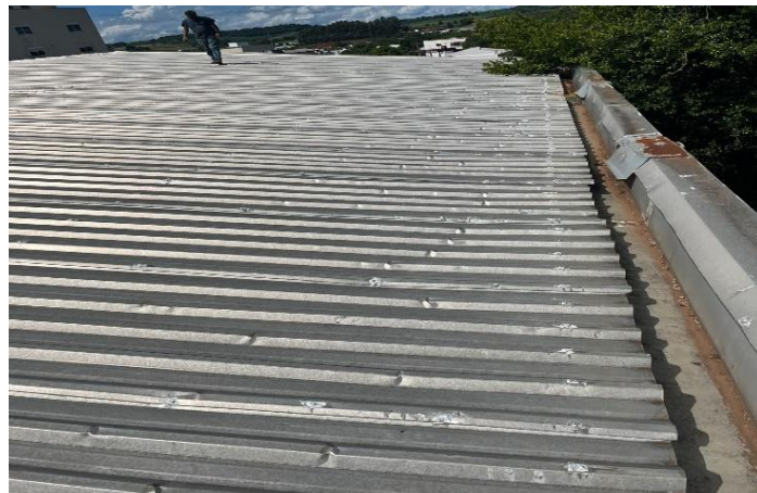
Vista do telhado
