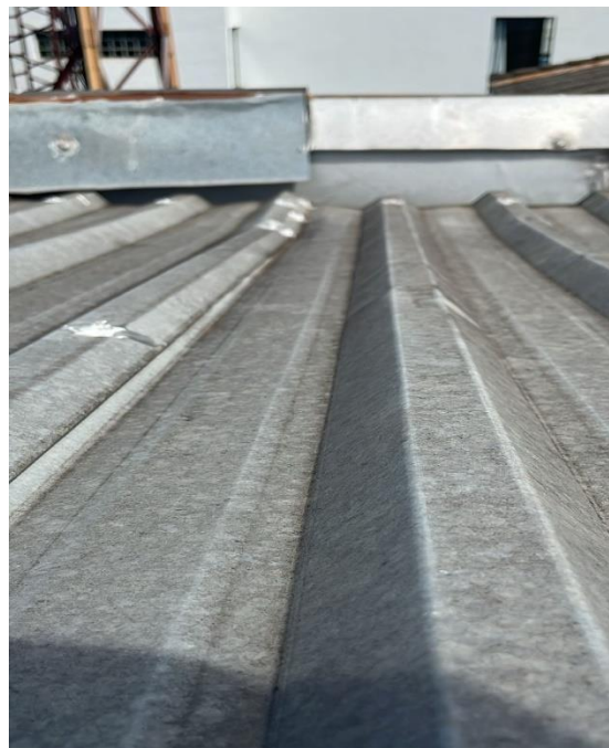
Vista do telhado
