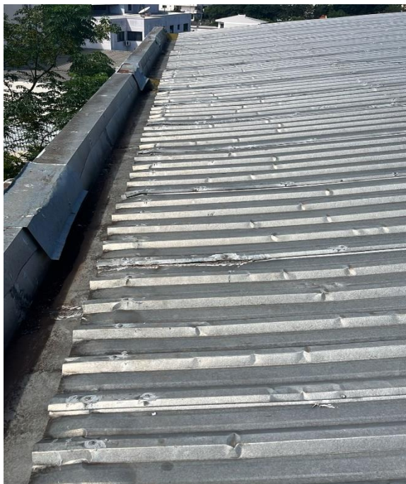
Vista do telhado
