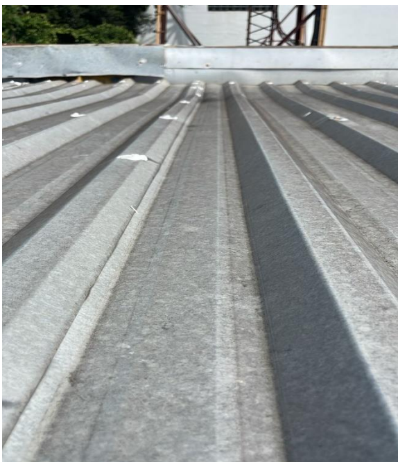
Vista do telhado
