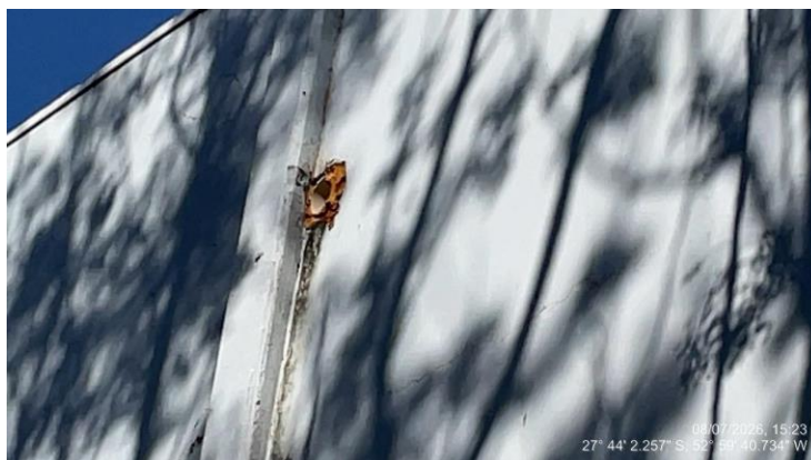
Vista do local do tubo de queda a executar na fachada norte
