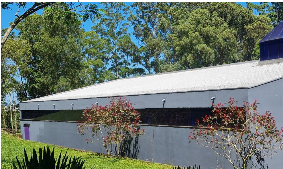
Imagem 07: Telhado com platibanda.
