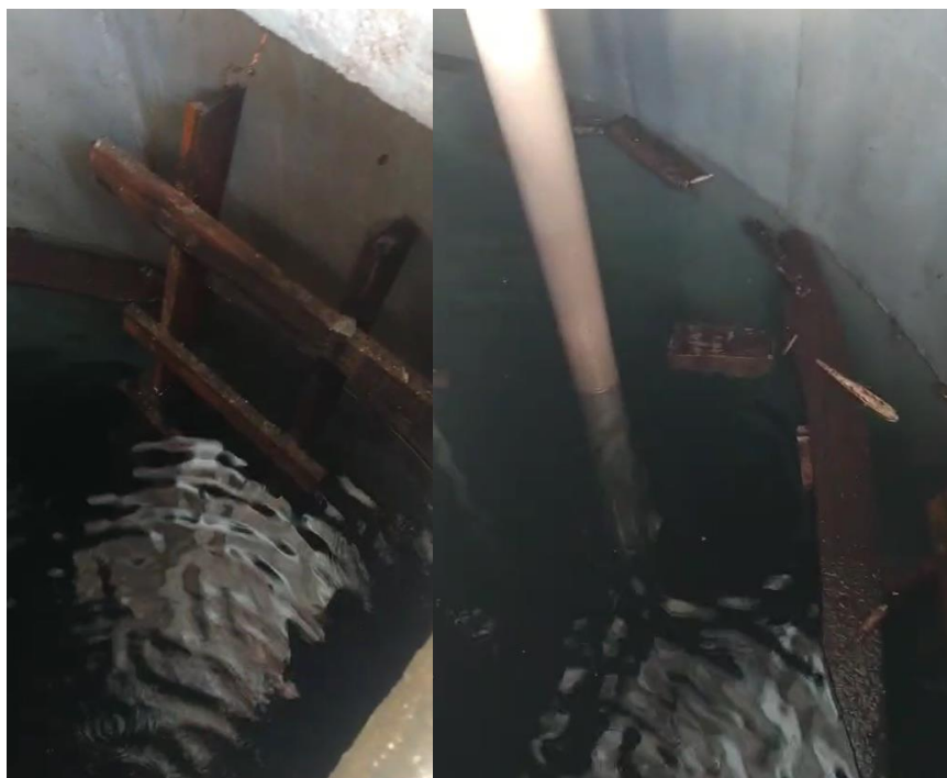
Figura 3 - Caixa de água do meio
