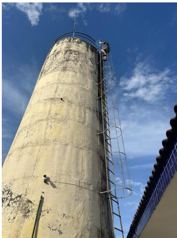
Figura 1 - Estrutura caixa de água
