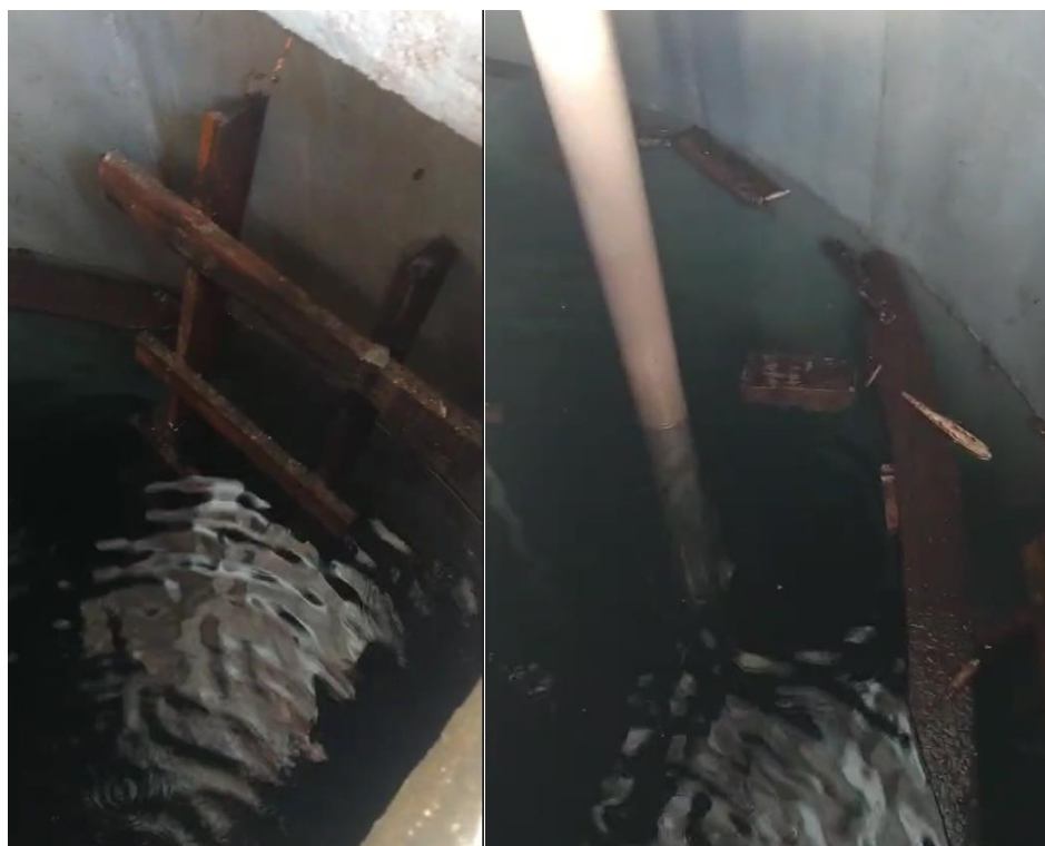
Figura 1 - Caixa de água do meio
