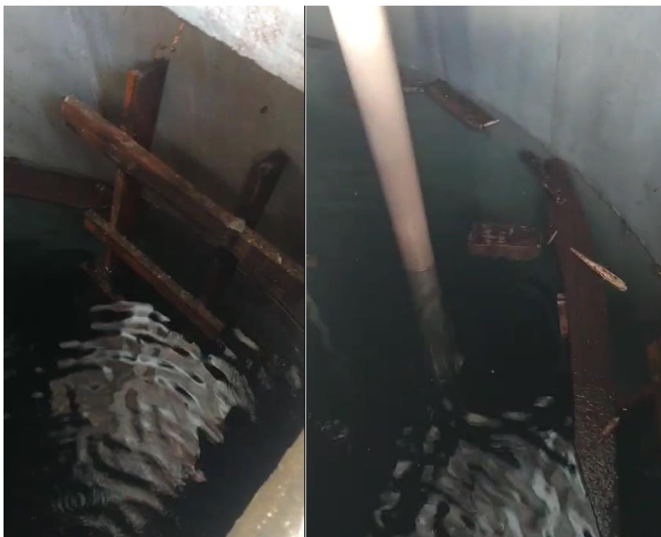
Figura 1 - Caixa de água do meio
