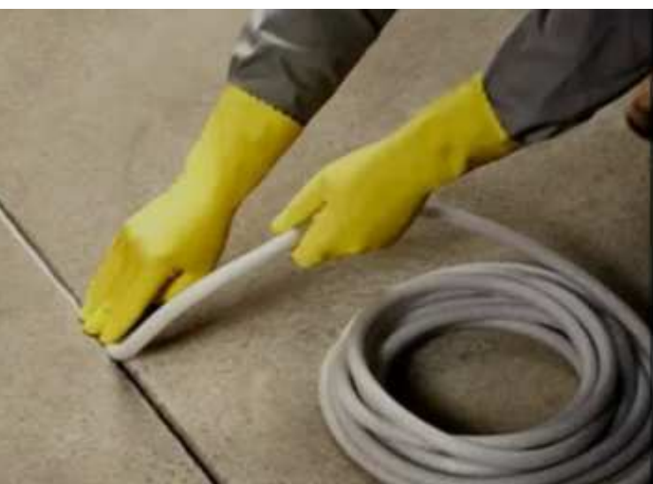
DETALHE JUNTA DE RETRAÇÃO s/e
