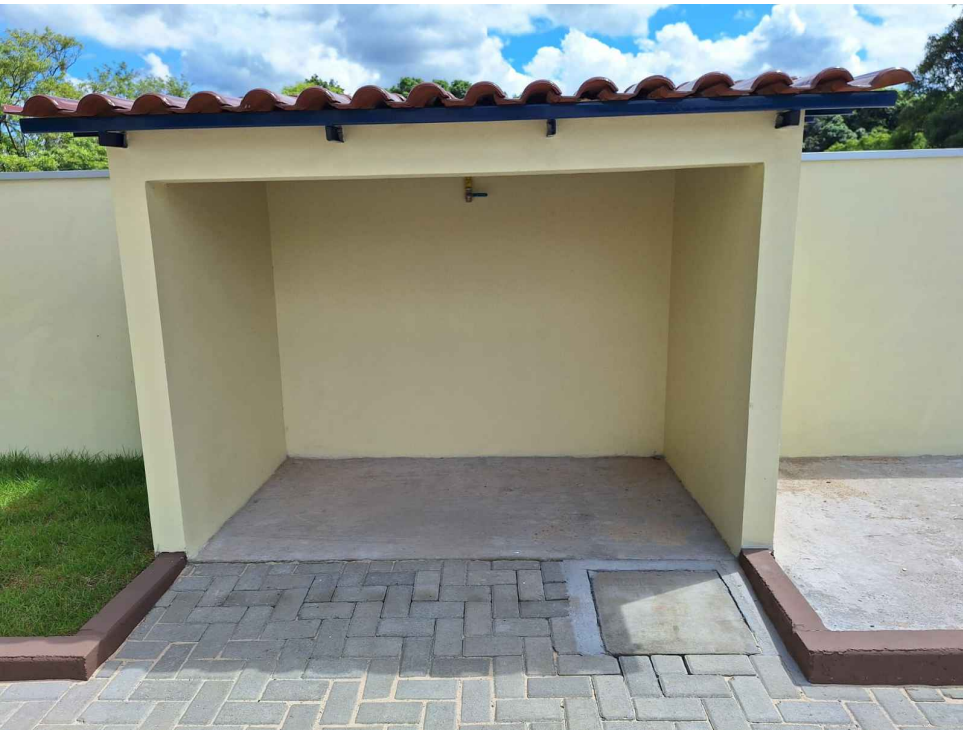
IMAGEM DO ABRIGO EXISTENTE
