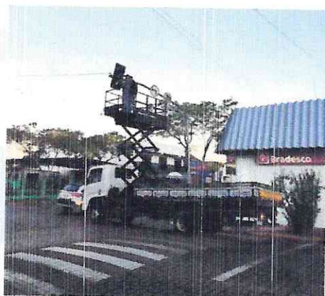
Equipe técnica especializada realizando uma implantação de solução semafórica.
