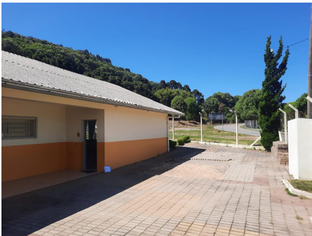
Prédio existente e local onde será a nova sala.
