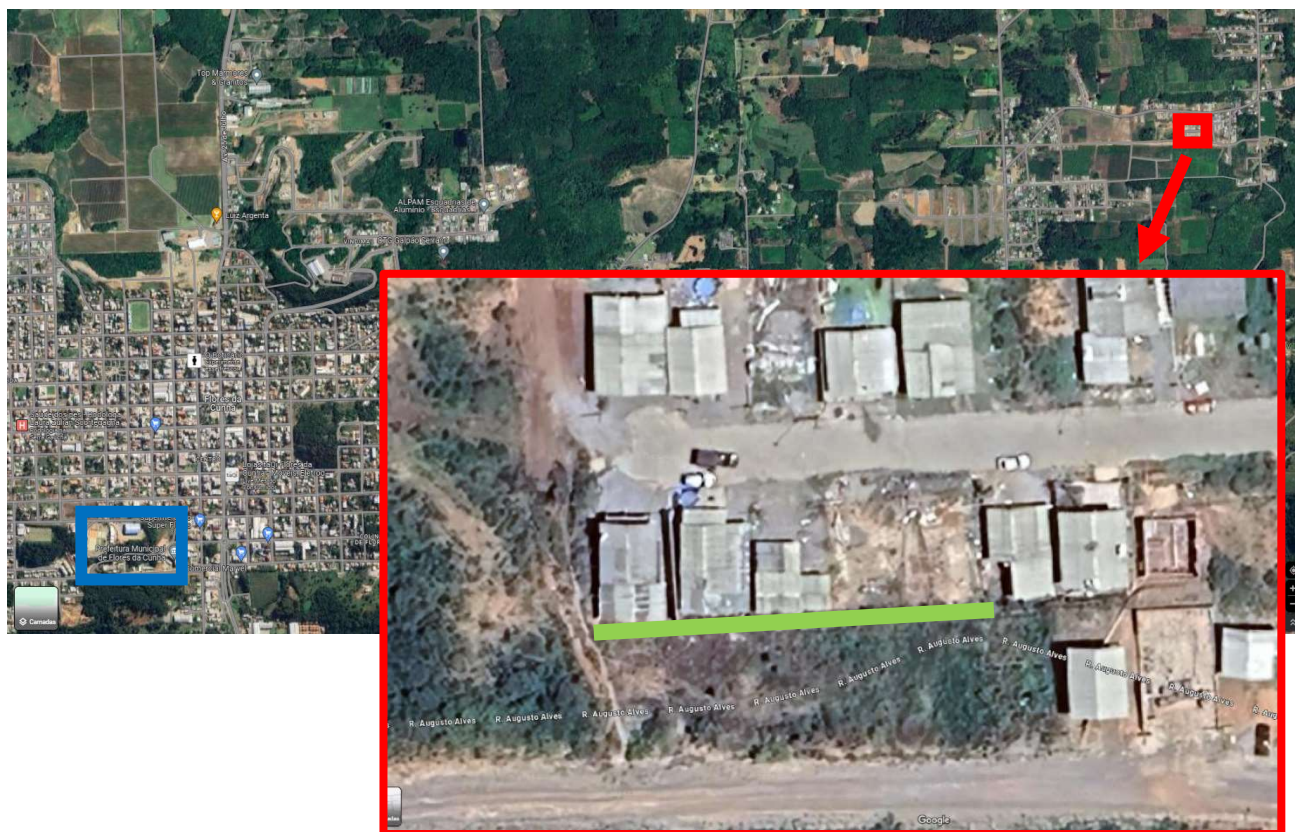
IMAGEM 01: Localização da contenção do maciço de terra (vermelho), prefeitura municipal (azul) e contenção (verde).
