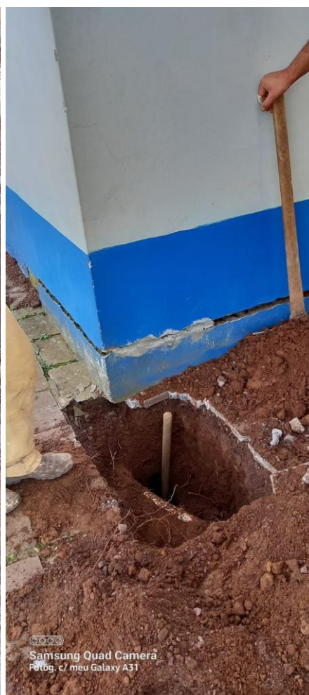
Inspecção do local com identificação de presença de esgoto líquido sob a calçada.
