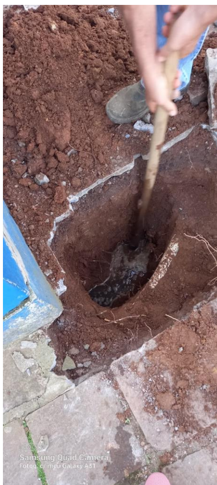
Inspecção do local com identificação de presença de esgoto líquido sob a calçada.
