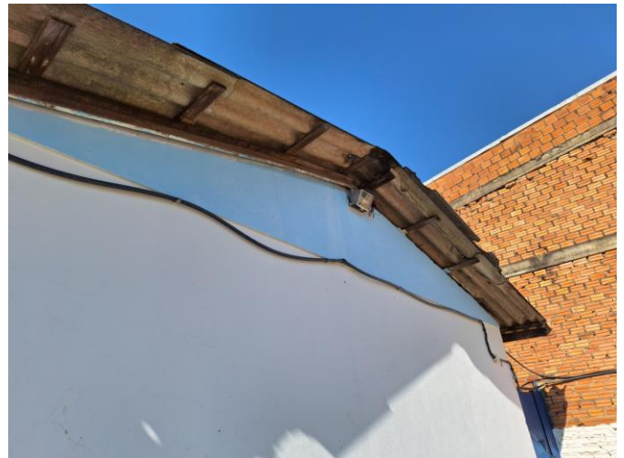
Imagem 5 e 6 – Extremidades da cobertura com estrutura em situação precária.
