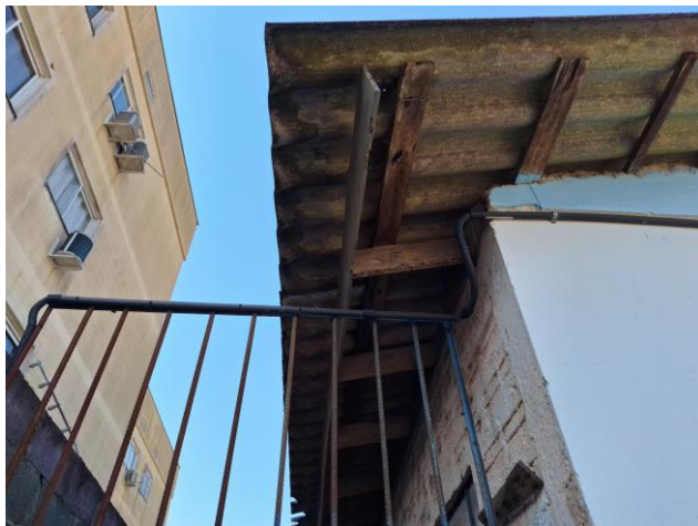
Imagem 5 e 6 – Extremidades da cobertura com estrutura em situação precária.
