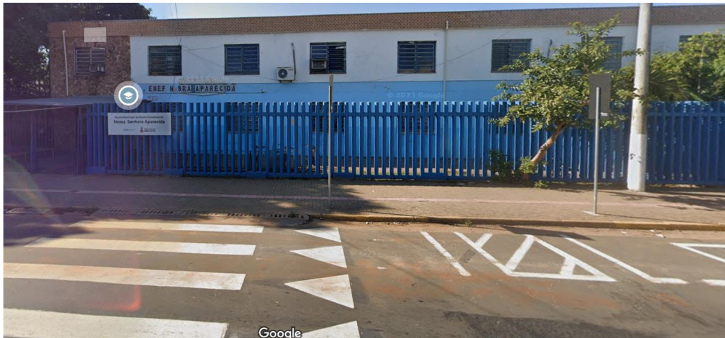
Imagem 8 – fachada da edificação.
