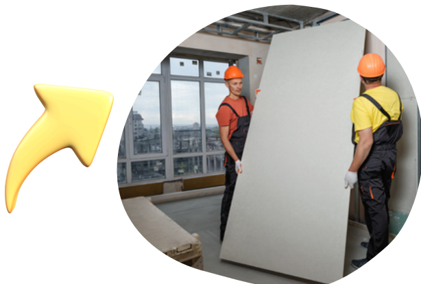
Figura 13- Arquivo Canva - Divisórias interna (drywall)
