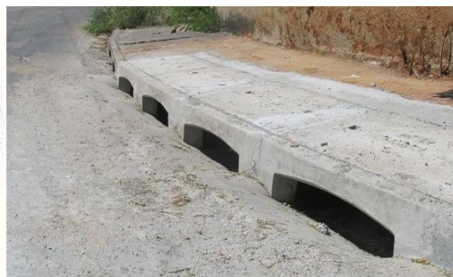
Figura 5: Boca de Lobo a executar.
