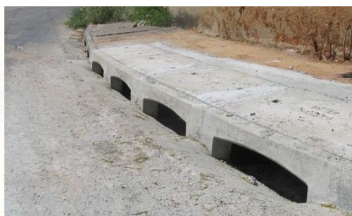
Figura 5: Boca de Lobo a executar.
