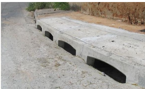
Figura 5: Boca de Lobo a executar.
