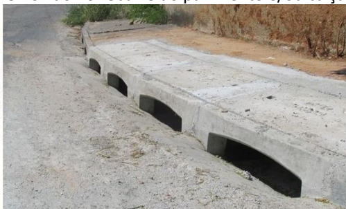
Figura 5: Boca de Lobo a executar.
