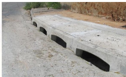
Figura 5: Boca de Lobo a executar.
