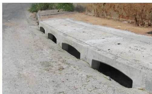
Figura 5: Boca de Lobo a executar.
