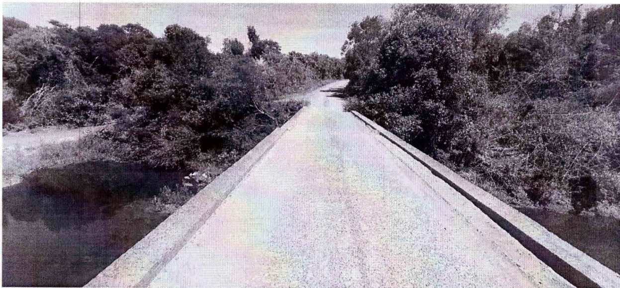
Figura 02 – Vista Superior da Ponte sobre o Arroio Ituzinho. (Foto Eng Thiago Piovezan)
