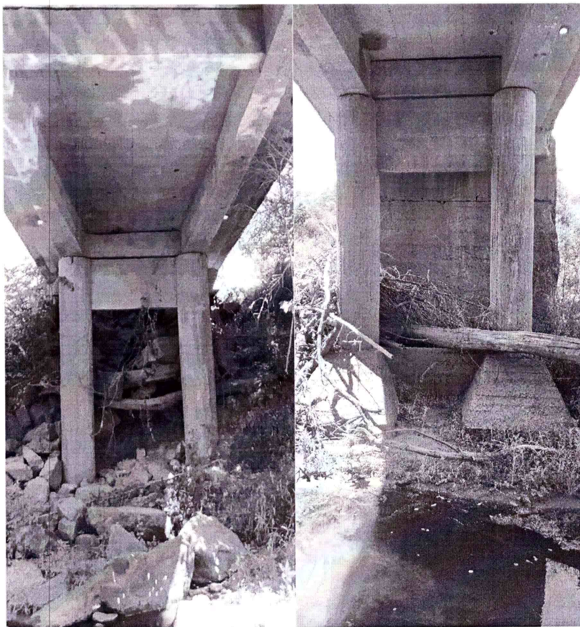
Figuras 08 e 09 – Vista dos pilares da ponte a ser recuperada. (Fotos Eng Thiago Piovezan)
