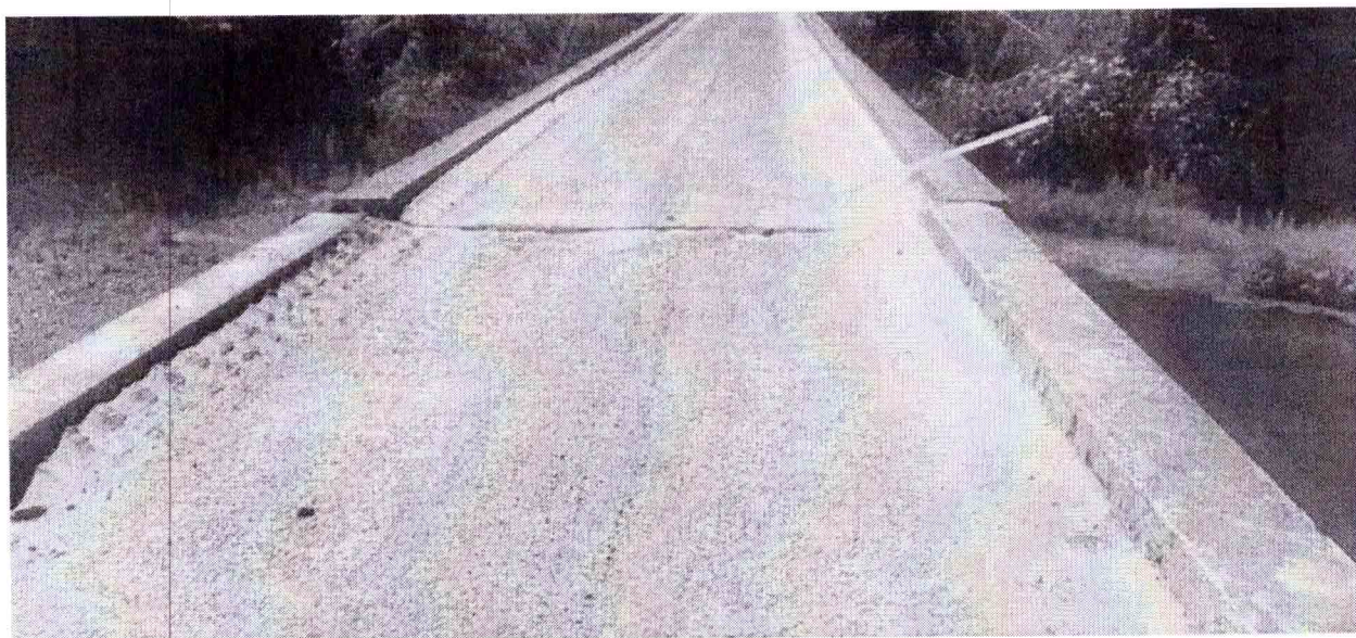
Figura 04 – Vista Superior da Ponte sobre o Arroio Ituzinho. (Foto Eng Thiago Piovezan)
