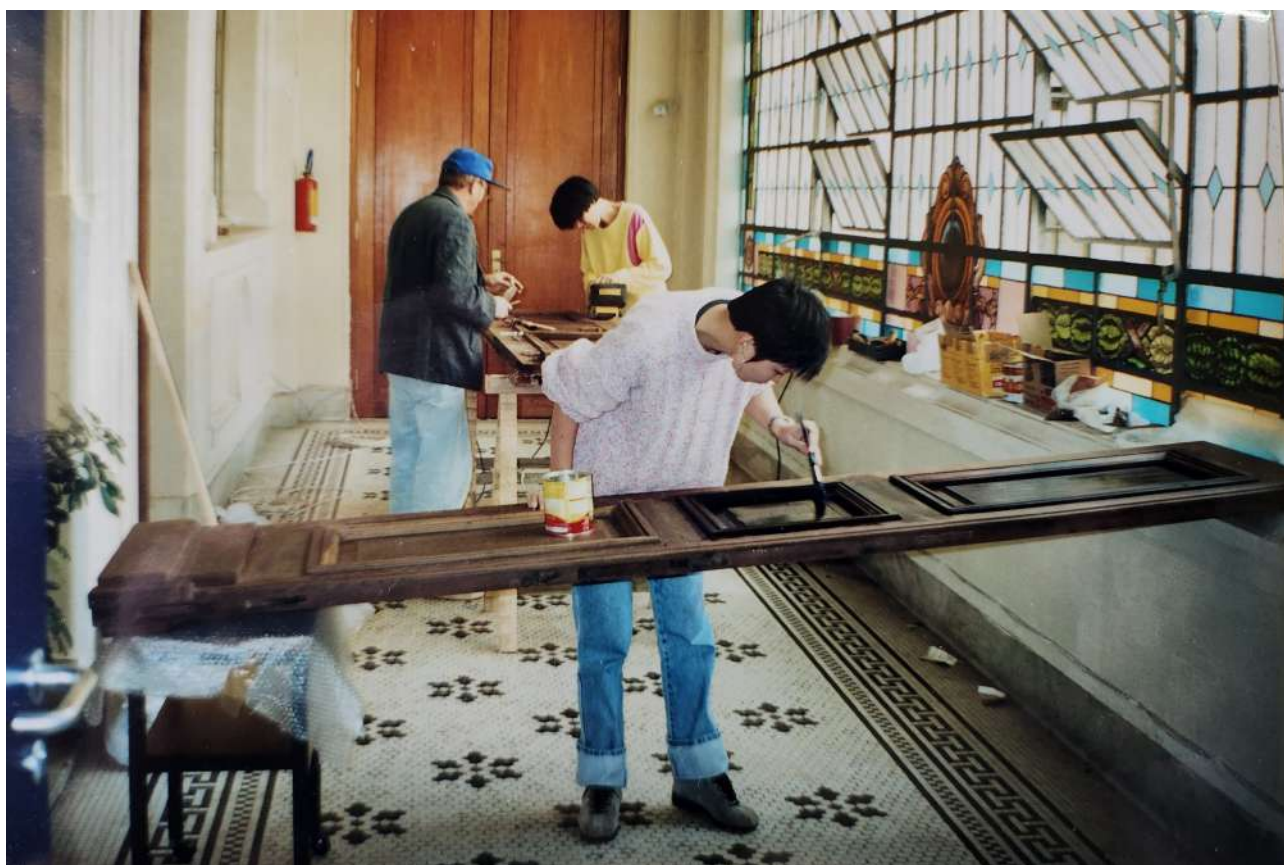
Restauro das Portas da Estação Júlio Prestes
