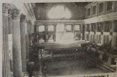
O Grande Hall, onde a sala de concertos foi instalada: 1 quilômetro quadrado de área, com pé-direito de 24 metros, sustentado por 32 enormes colunas
