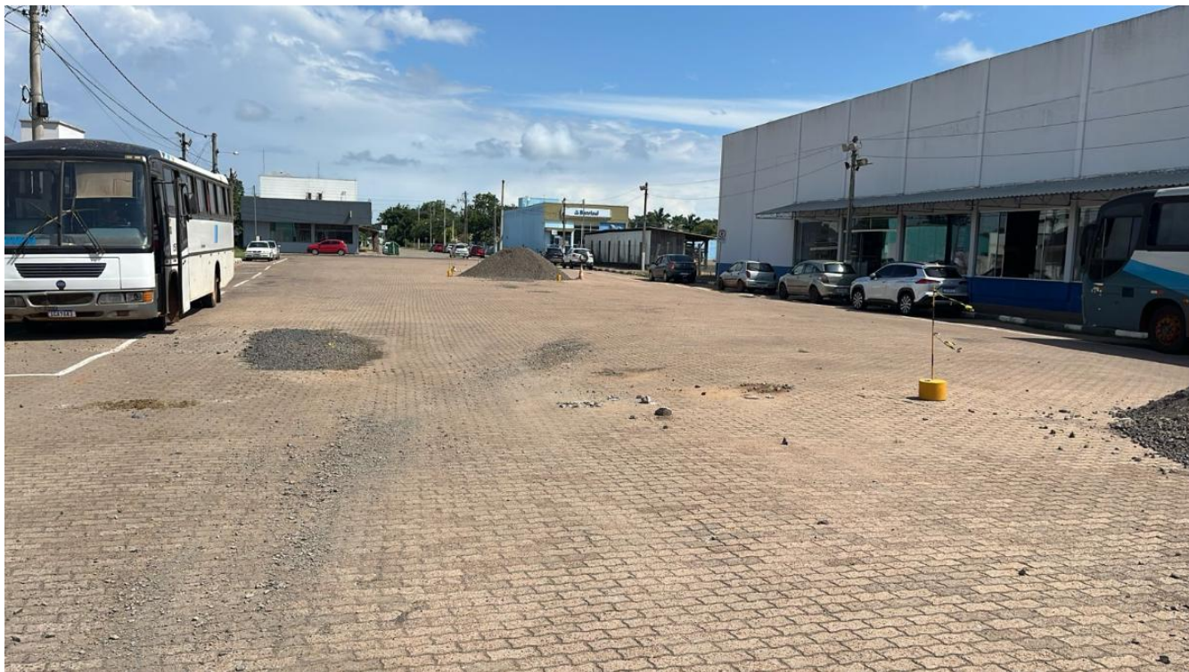
Foto 03/03 – Local onde será executada as obras
