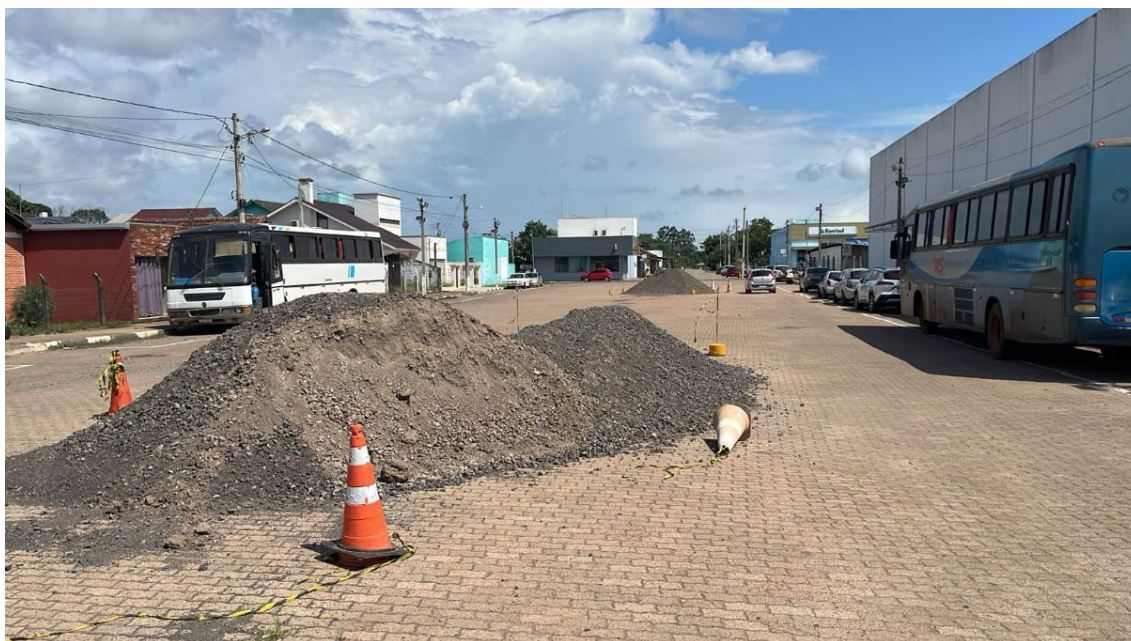
Foto 02/03 – Local onde será executada as obras
