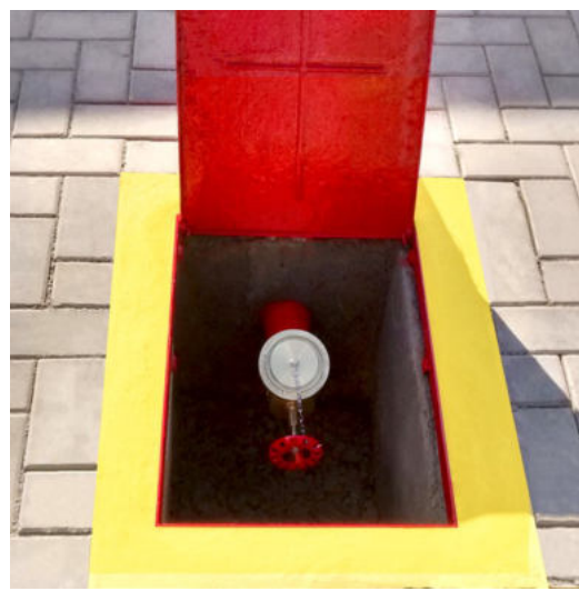
DT Hidrante de Recalque Sem Escala
