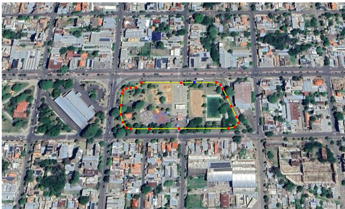
Imagem 02 – Trecho a ser recapeado Fonte: Google maps
