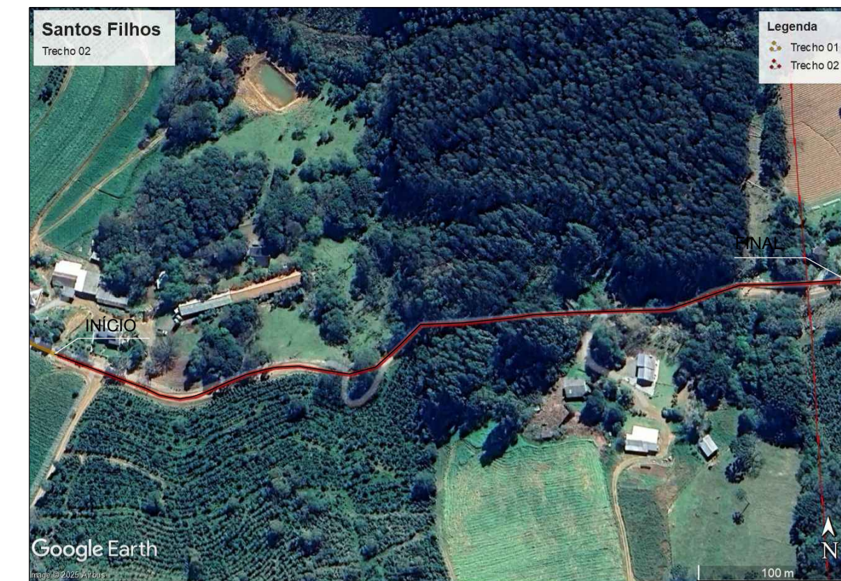
SANTOS FILHOS Trecho 02 PAVIMENTAÇÃO EM BLOCO DE CONCRETO (LARGURA: 6,00 m; EXTENSÃO: 550,00 m)
