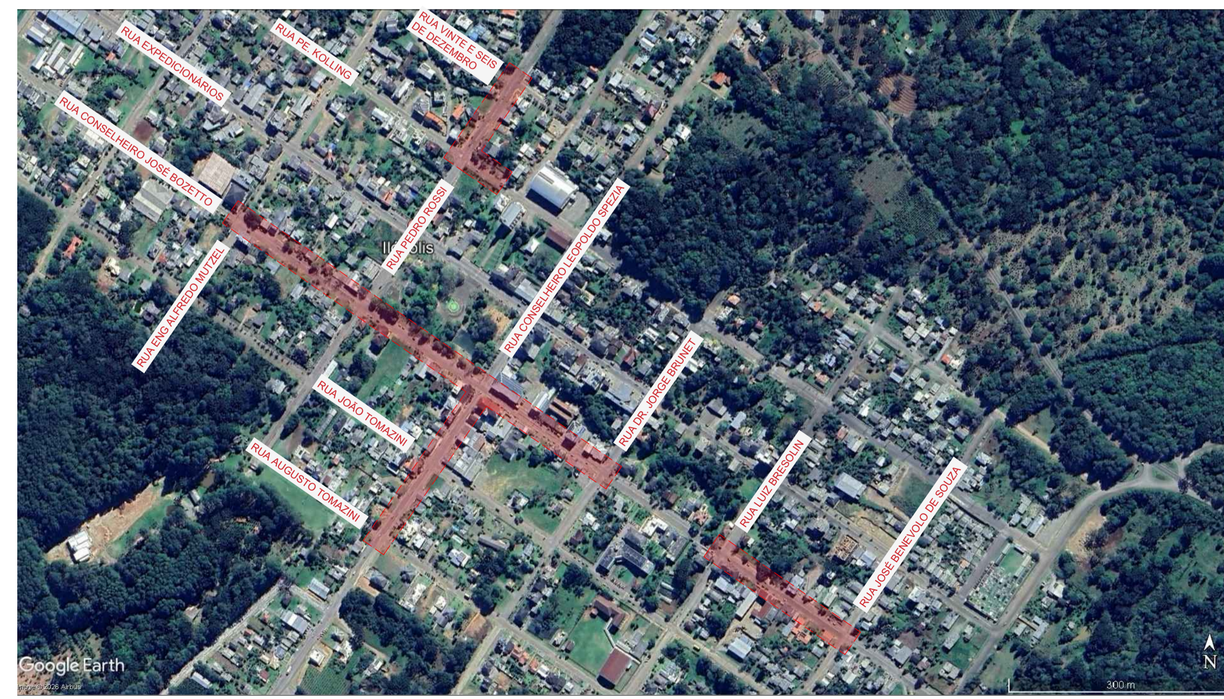
ÁREAS DE INTERVENÇÃO (EXECUÇÃO DE REDE DE DRENAGEM OU ADEQUAÇÃO DOS CANTEIROS CENTRAIS)
