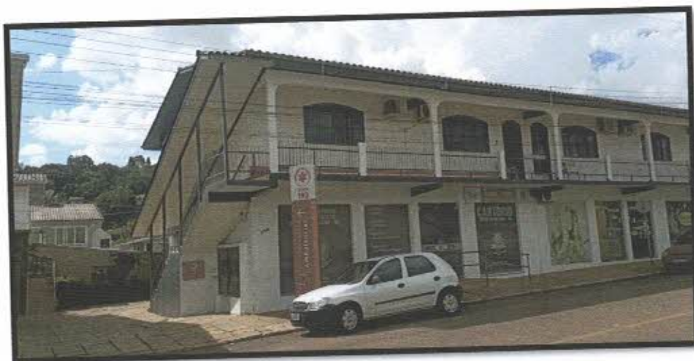
Figura 1 – Vista geral da Edificação – Fachada principal
