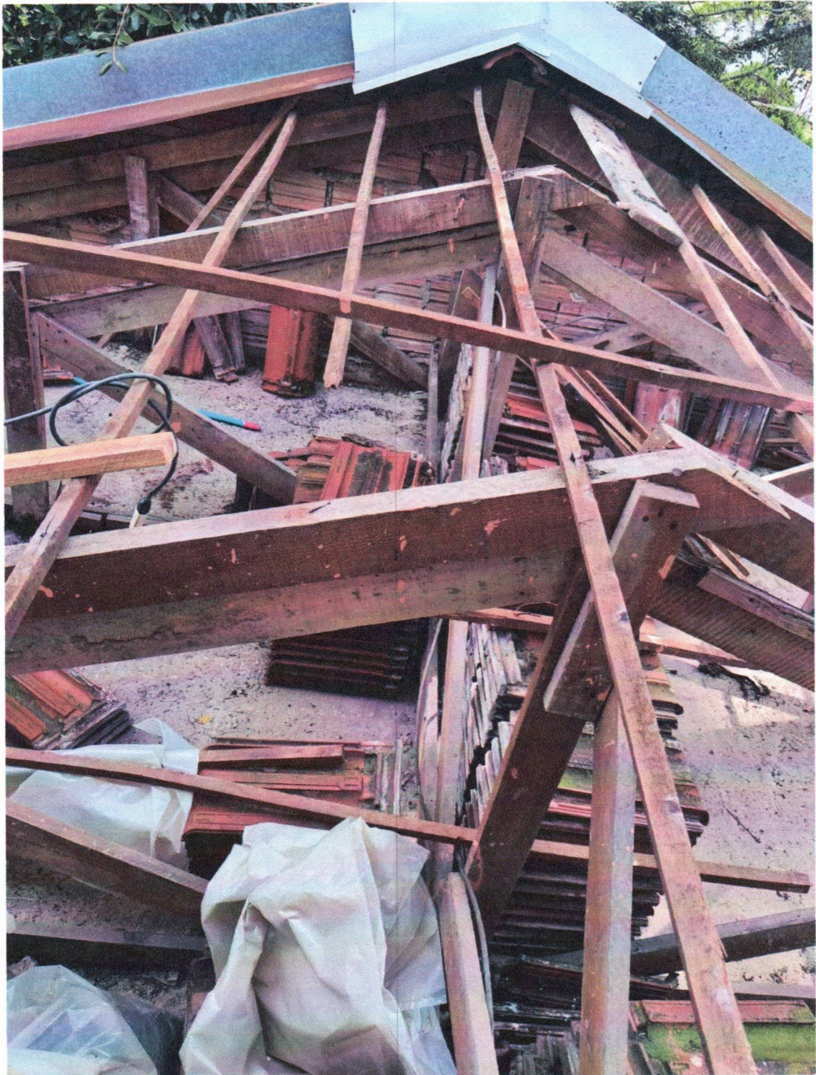
o reparo do telhado sobre os banheiros principais do térreo
