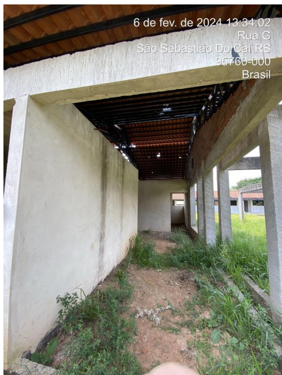
Foto 31: Vista Interna Corredor – Bloco F
