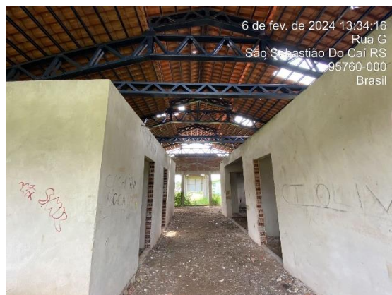
Foto 33: Vista Interna – Bloco A
