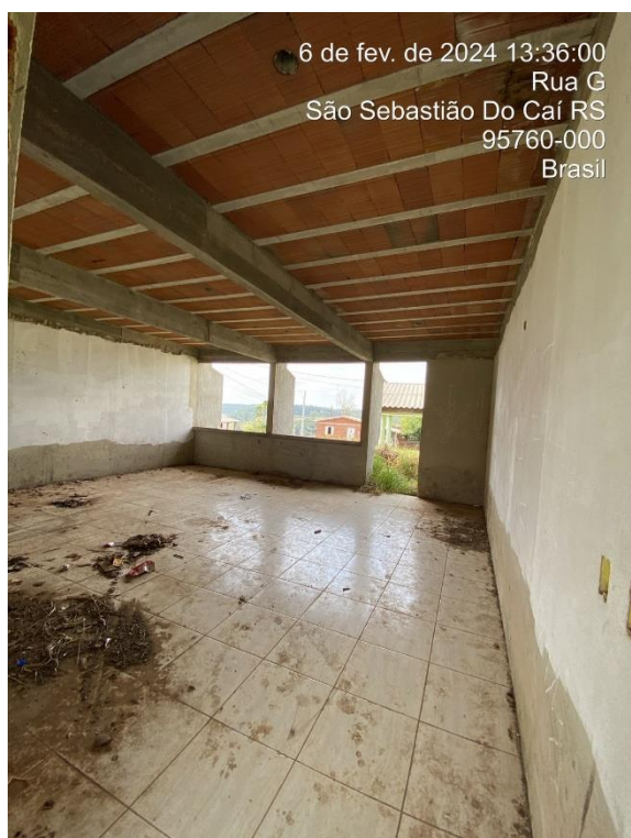
Foto 19: Vista Interna Sala – Bloco C
