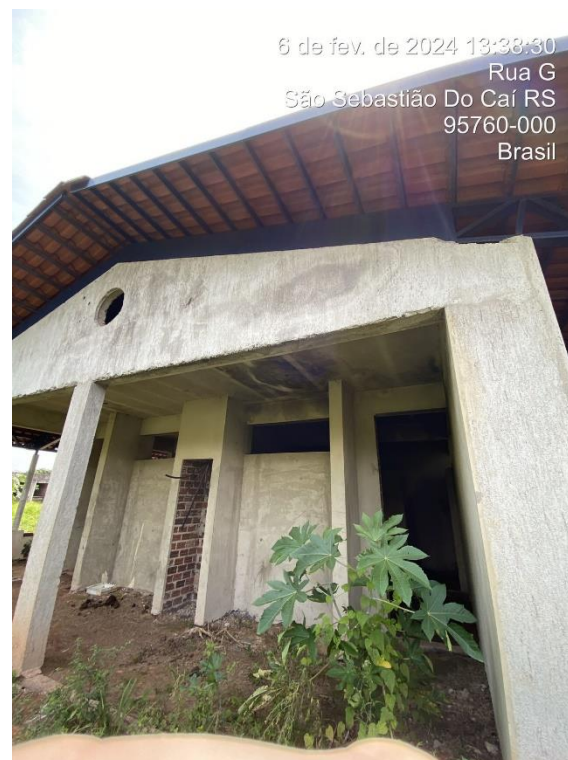
Foto 08: Acesso Sanitários Bloco E1
