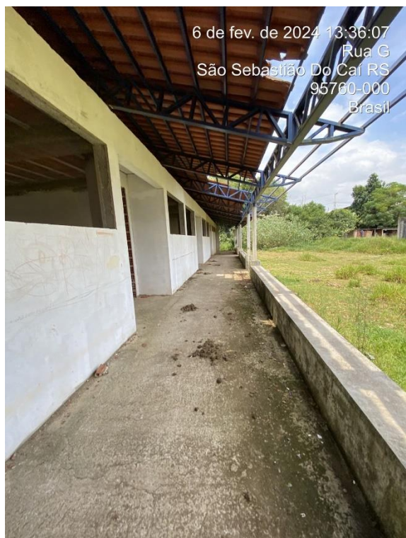
Foto 17: Corredor Bloco E1
