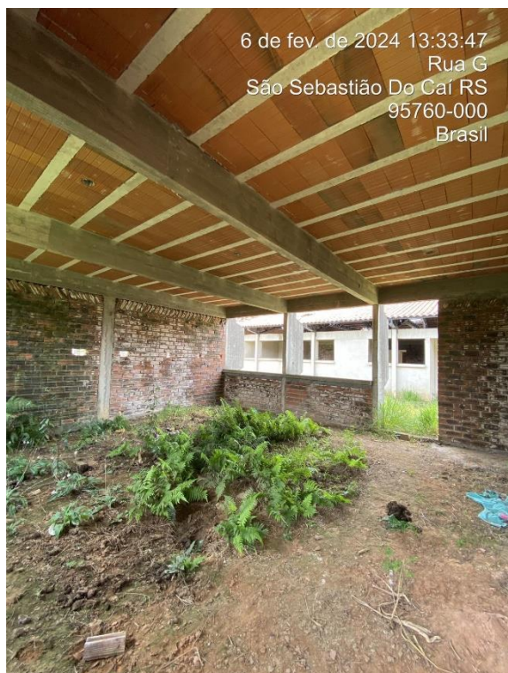
Foto 29: Vista Interna Sala – Bloco F
