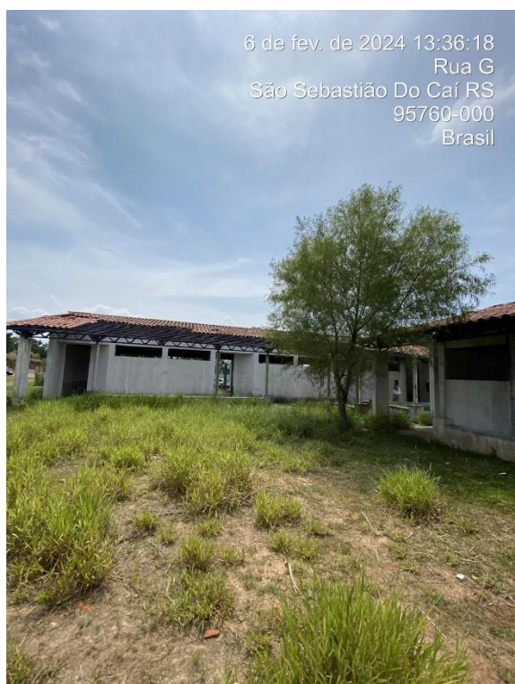
Foto 15: Vista Externa – Bloco C
