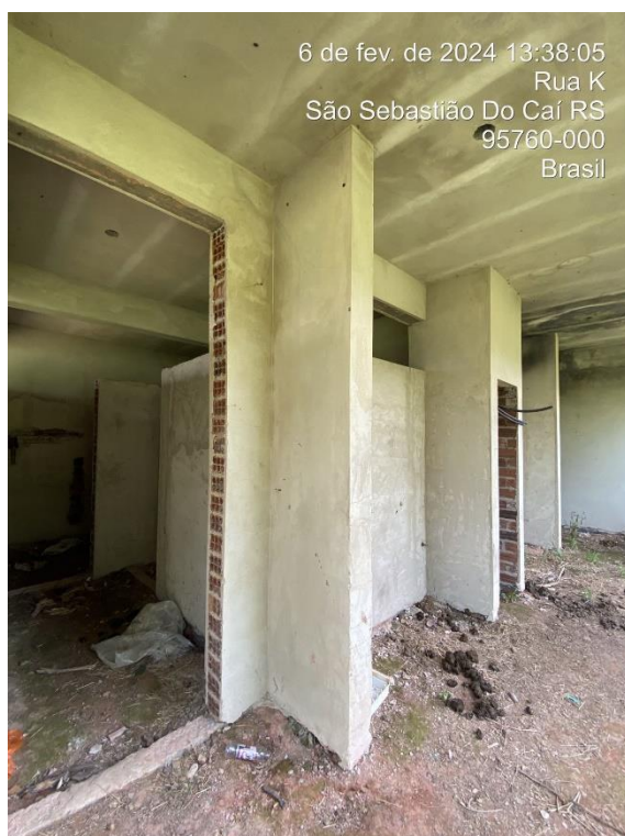
Foto 09: Acesso Sanitários Bloco E1
