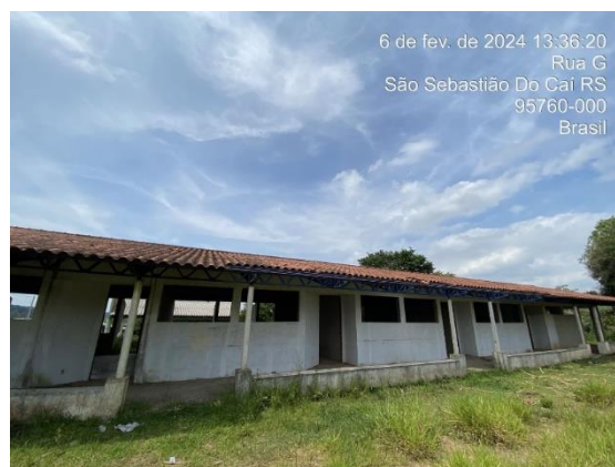
Foto 35: Vista Externa – Bloco E1
