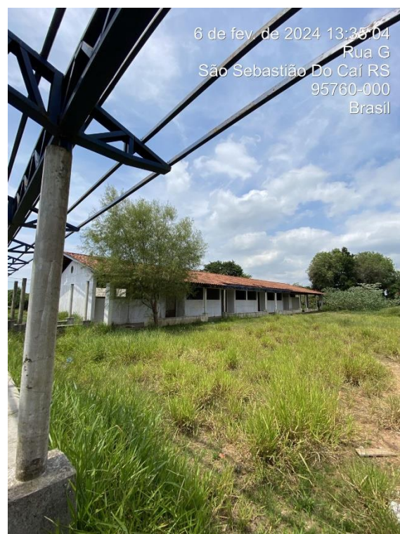
Foto 24: Vista Externa – Bloco E1
