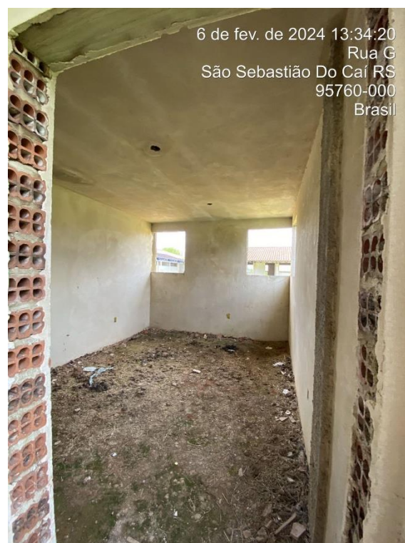
Foto 10: Sanitários Bloco E1
