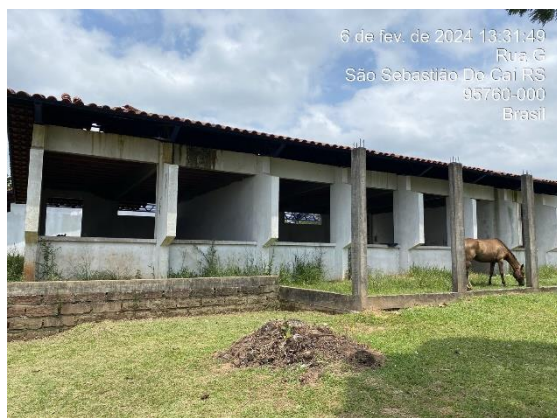
Foto 32: Vista Externa – Bloco F
