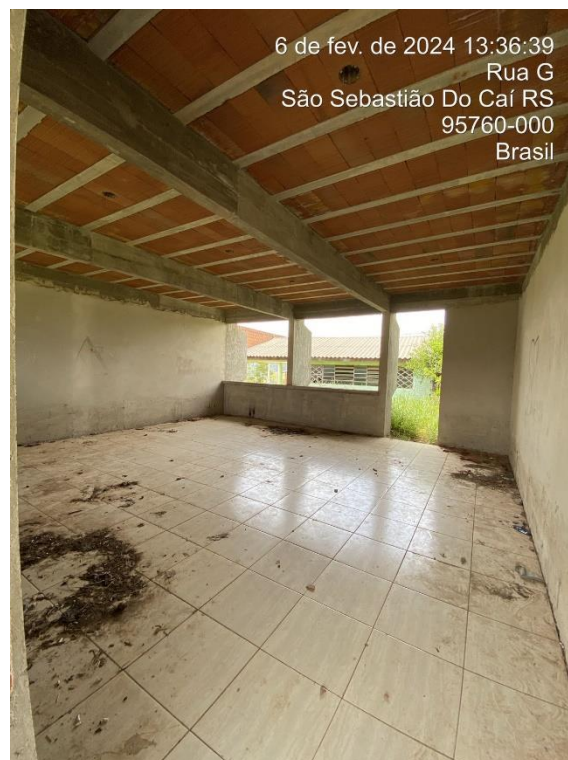
Foto 14: Vista Interna Sala de Aula – Bloco E1
