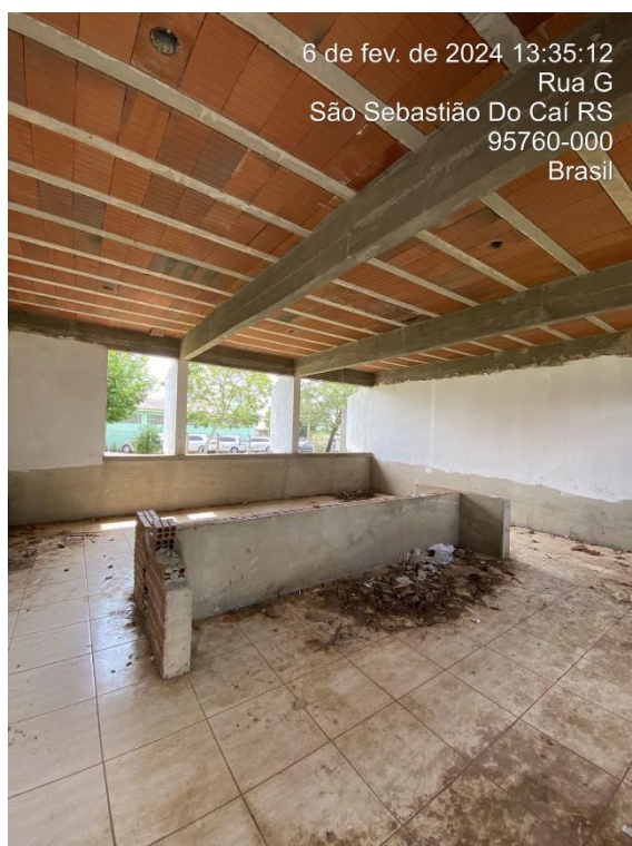
Foto 23: Vista Interna Sala – Bloco C
