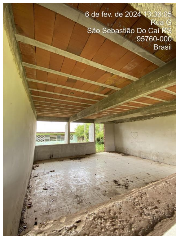
Foto 18: Vista Interna Sala – Bloco C
