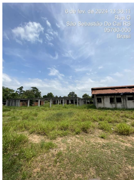
Foto 16: Vista Externa – Bloco D
