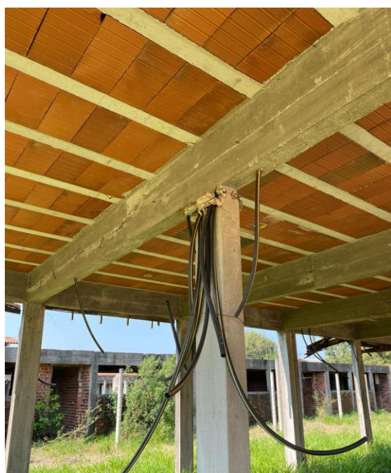
Foto 36: Vista Interna – Bloco E2
