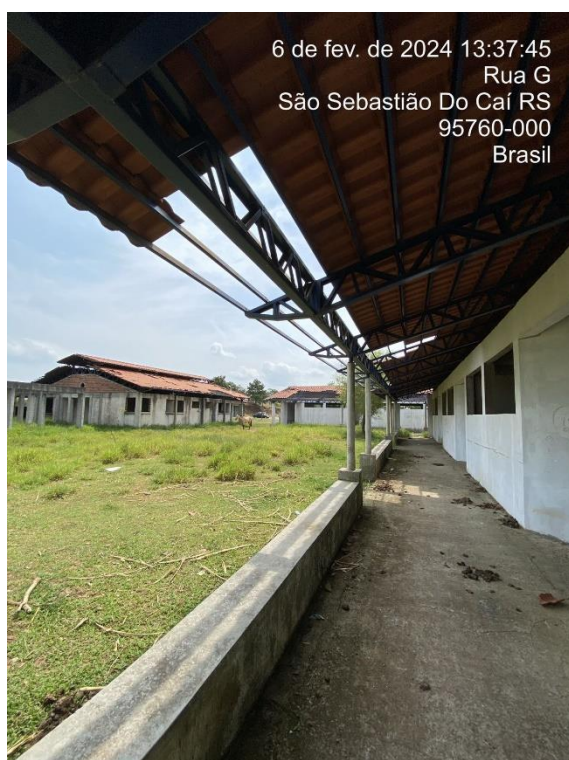
Foto 11: Corredor Bloco E1
