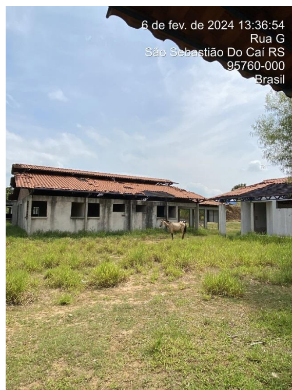
Foto 12: Vista Lateral Bloco A
