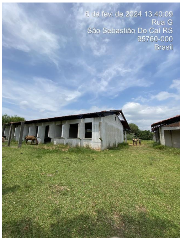
Foto 05: Vista Bloco C
