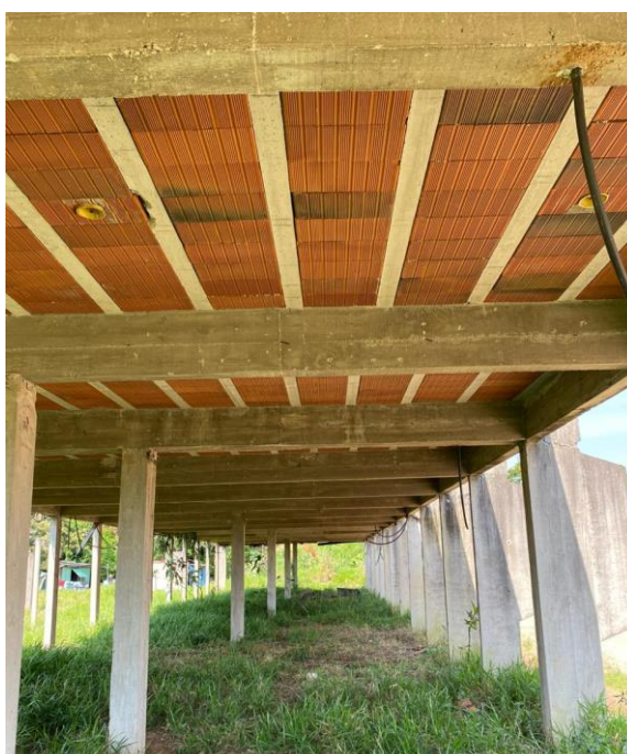
Foto 37: Vista Interna – Bloco E2
