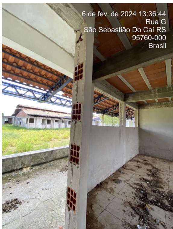
Foto 13: Vista Interna Sala de Aula – Bloco E1
