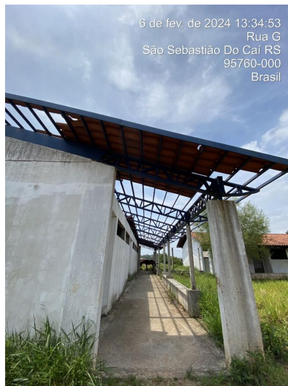
Foto 26: Vista Externa – Bloco C
