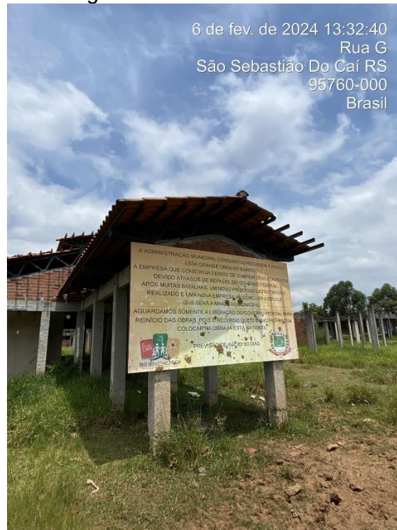
Foto 02: P (acesso) Placa de obra
