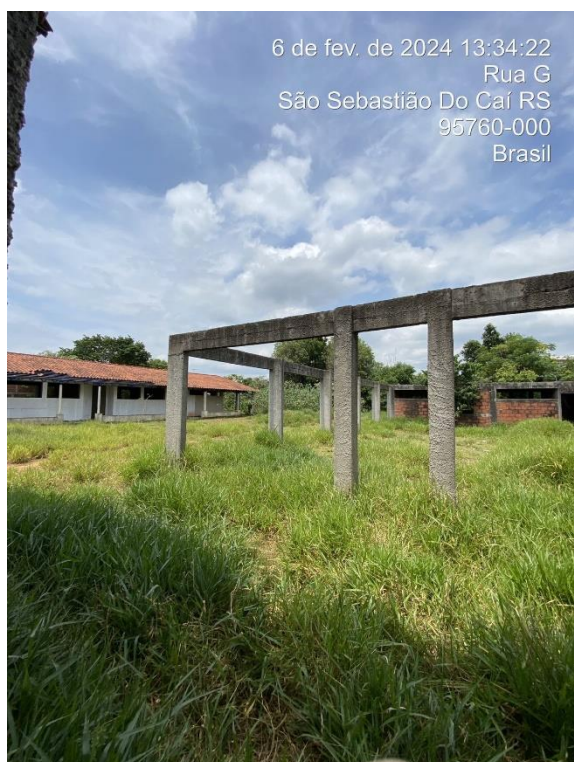
Foto 27: Vista Externa – Bloco D
