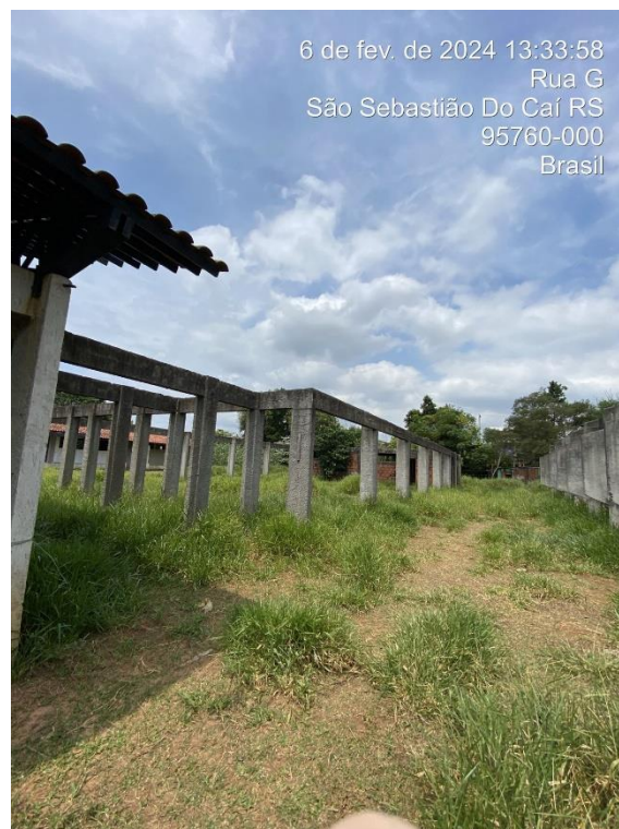
Foto 30: Vista Externa - Bloco D e F
