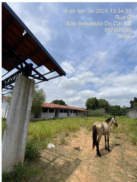
Foto 25: Vista Externa – Bloco E1
