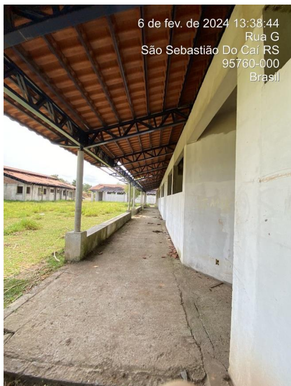
Foto 07: Corredor Bloco E1
