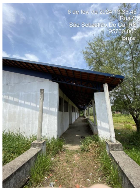
Foto 20: Vista Externa – Bloco E1
