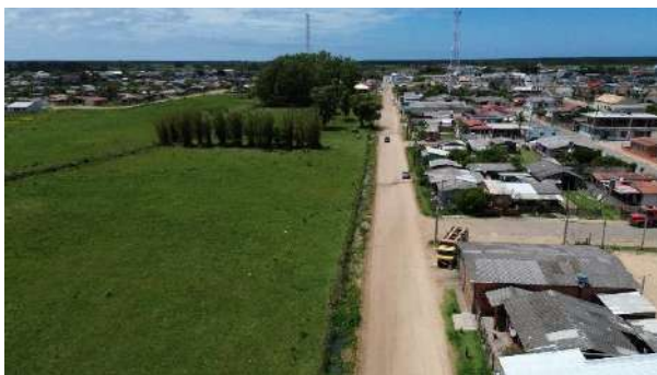
Figura 1. Rua Marcelo Gama em trecho não pavimentado
