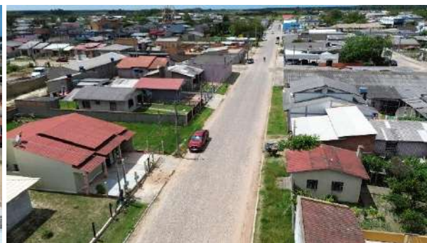
Figura 2. Rua Marcelo Gama em trecho pavimentado
