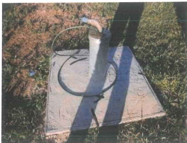
Foto 01 – Laje de proteção de no mínimo 1m 2 .
