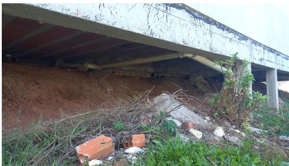
Imagem 12 – Sistema de esgoto instalado
