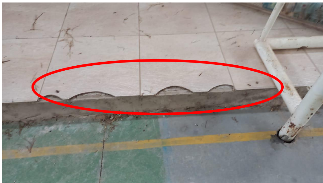
Imagem 02 – Piso cerâmico danificado (ser removido)
