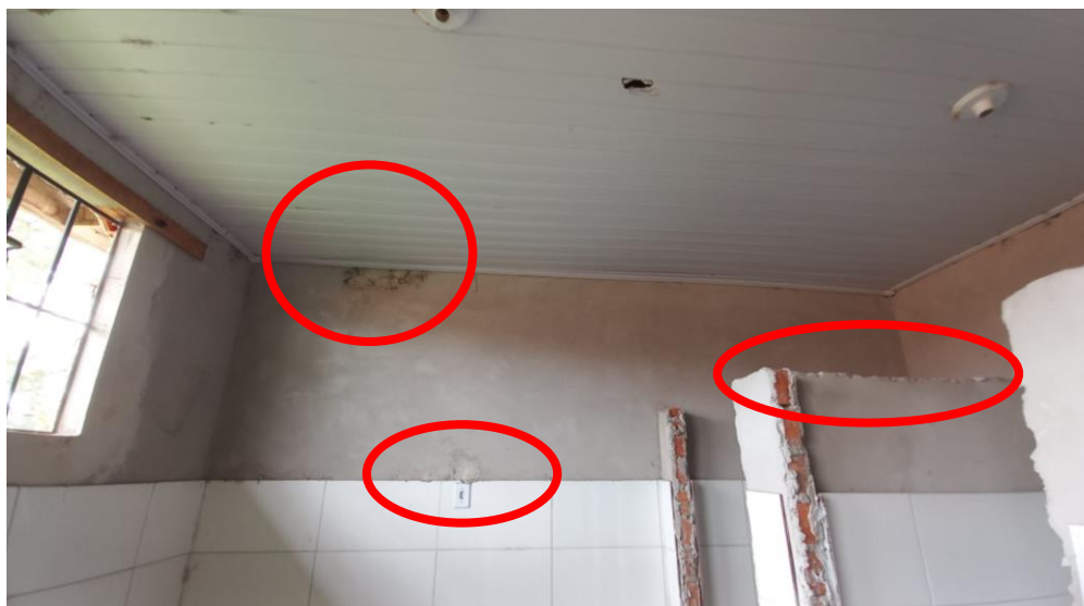
Imagem 07 – Correções no reboco e acabamentos
