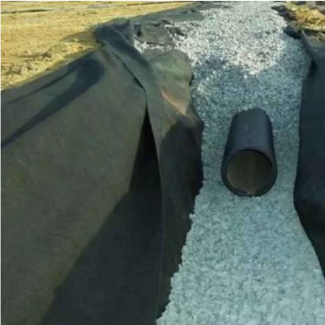
Imagem ilustrativo execução dreno com brita, tubo corrugado e manta bidin
