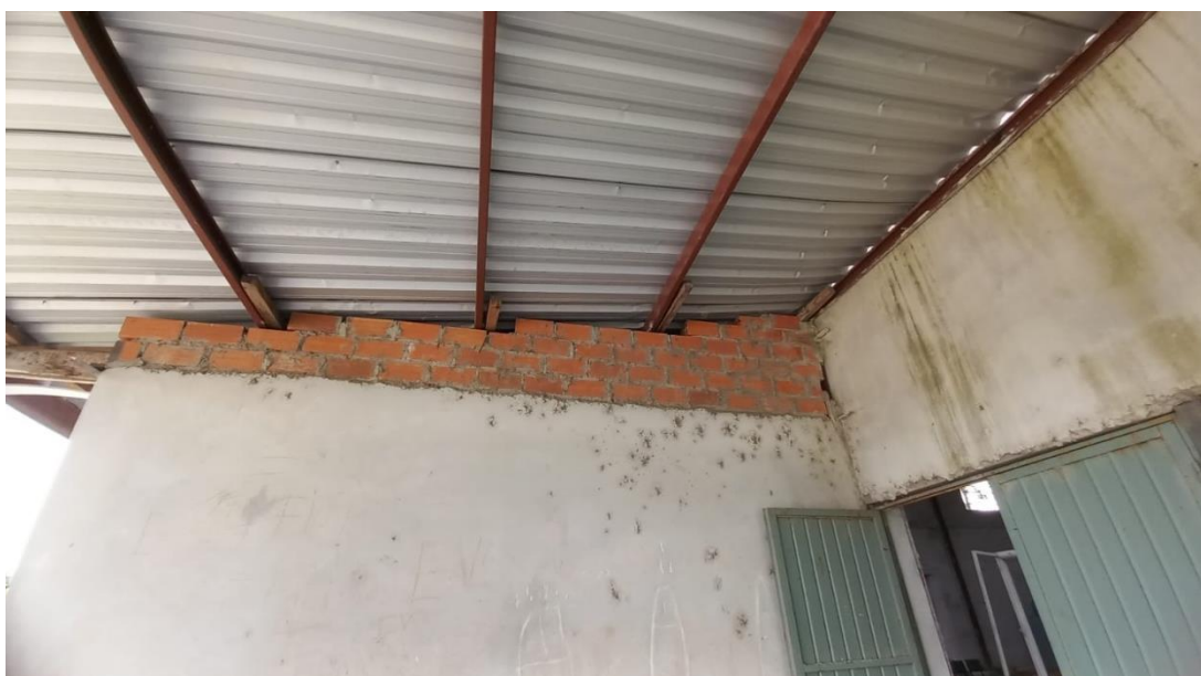
Imagem 05 – Oitão em alvenaria
