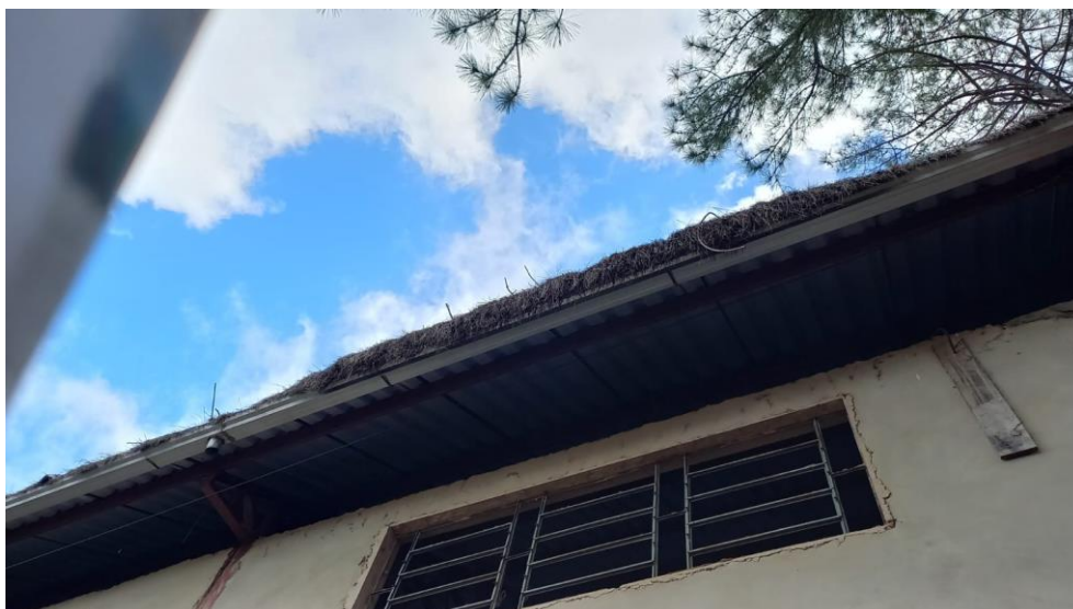
Imagem 08 – Calhas e cobertura do ginásio
