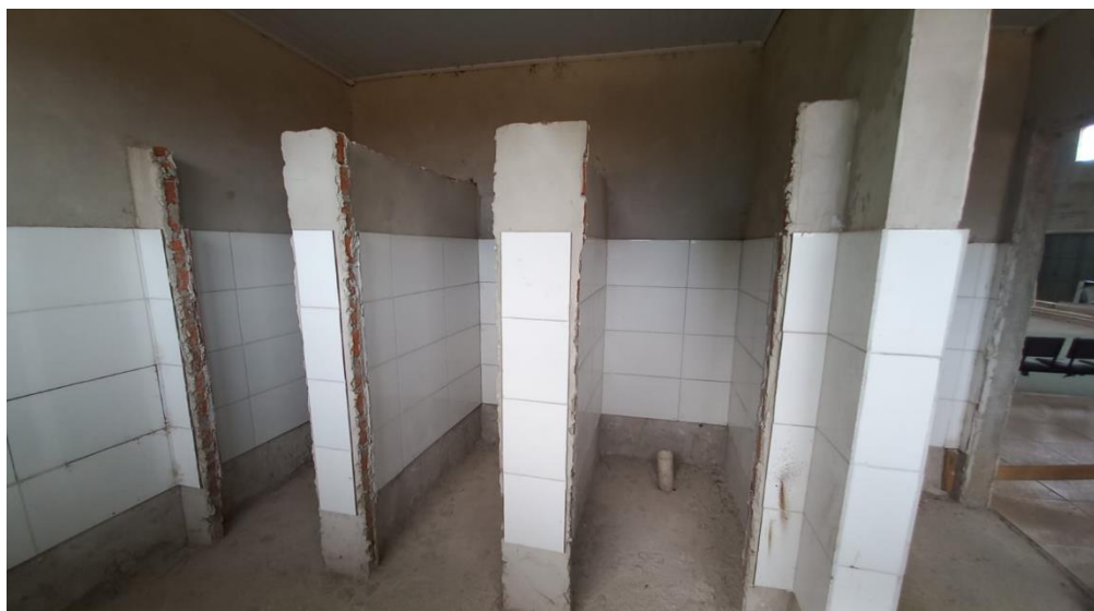
Imagem 06 – Revestimento cerâmico paredes não finalizadas
