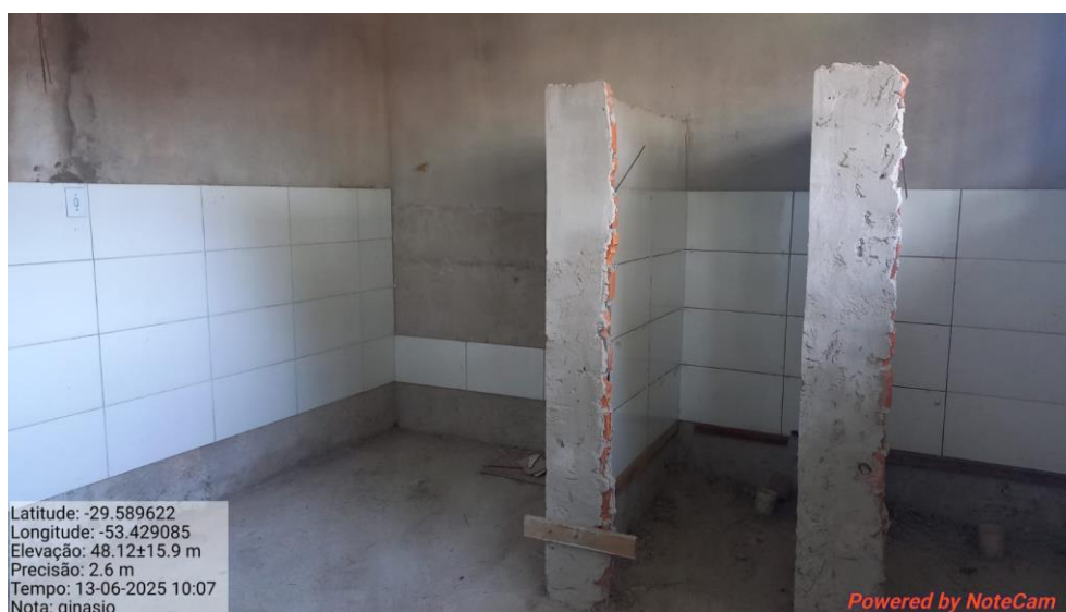
Imagem 13 – Tubos de PVC vasos sanitários
