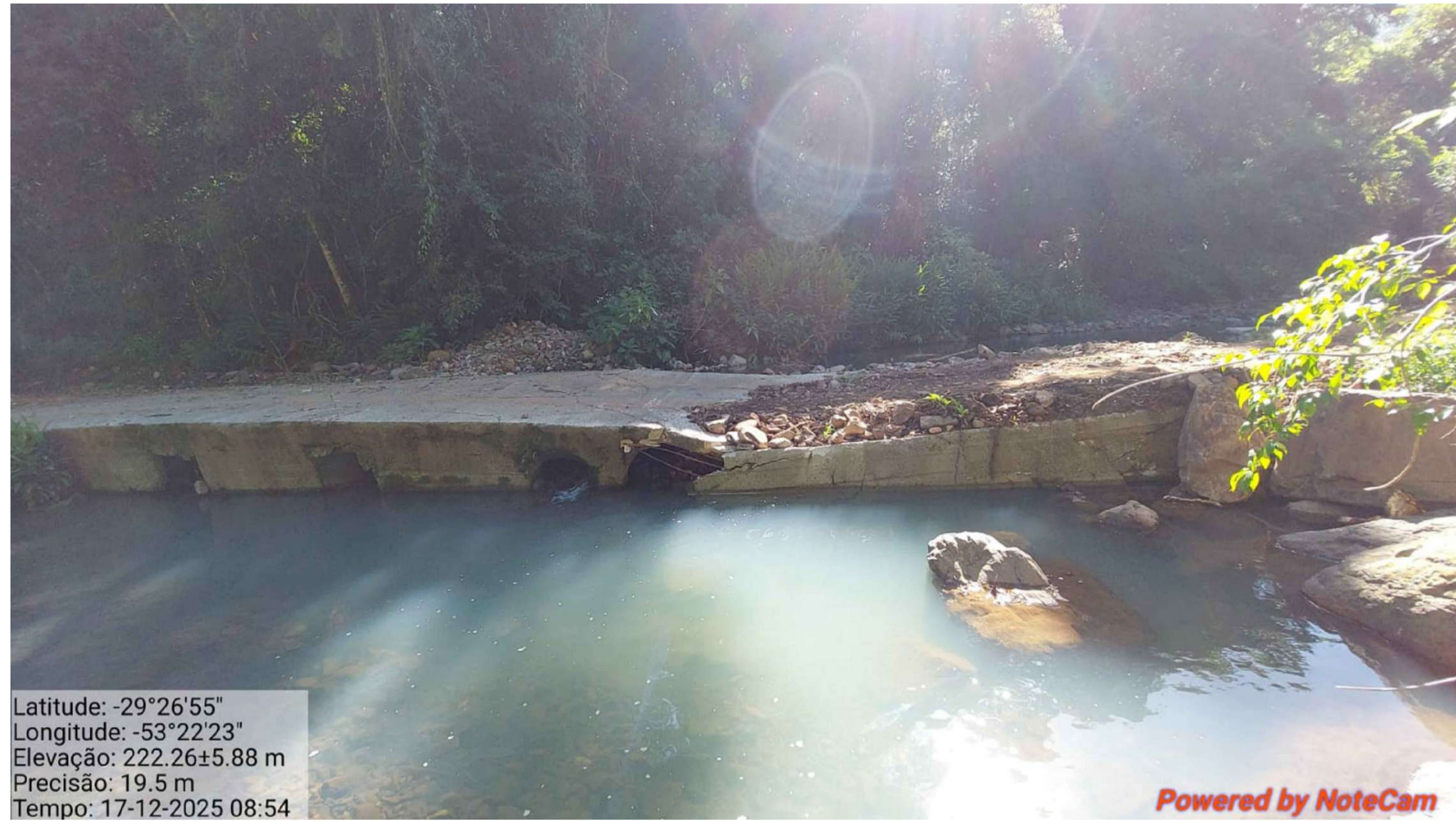
Imagem do local da Execução Passagem Molhada
