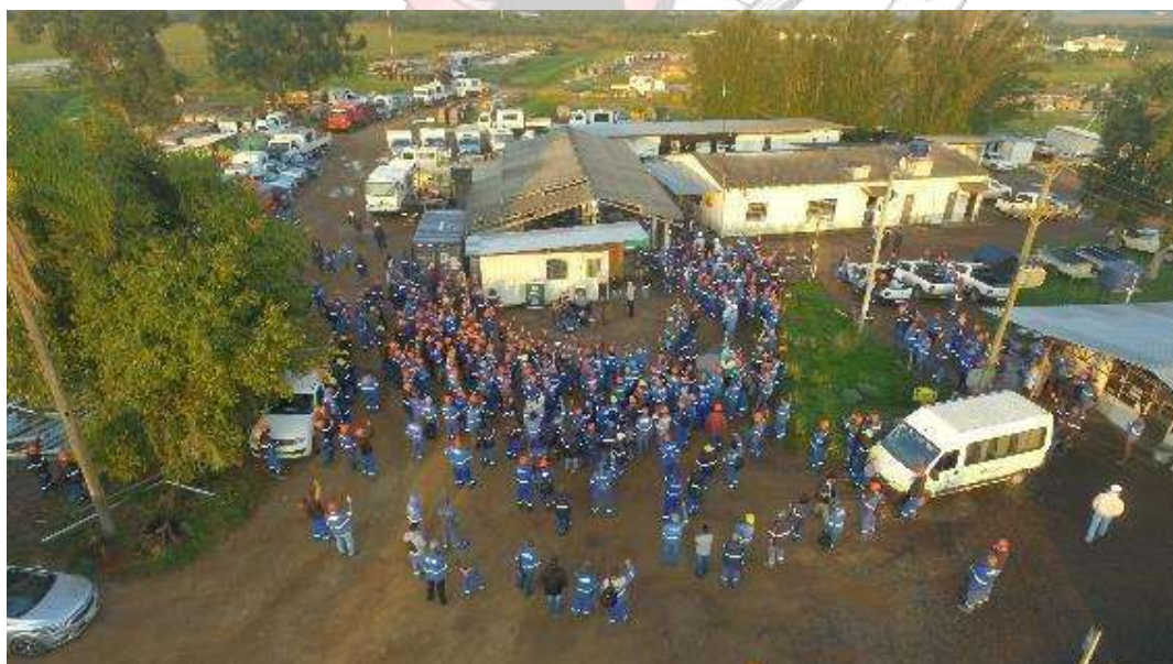
- Linha de Transmissão 525 KV – Capivari do Sul – Guaíba 3 / Governo Federal – (Santo Antônio da Patrulha/RS) - Show no canteiro de obras (2023)
