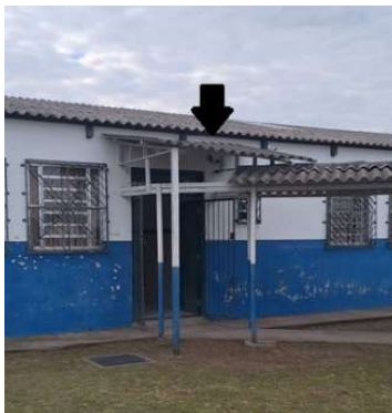
Detalhe da cobertura a ser retirada
