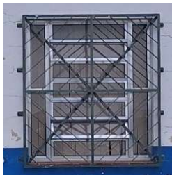
Detalhe da janela e grades
