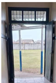
Detalhe da porta a ser substituída
