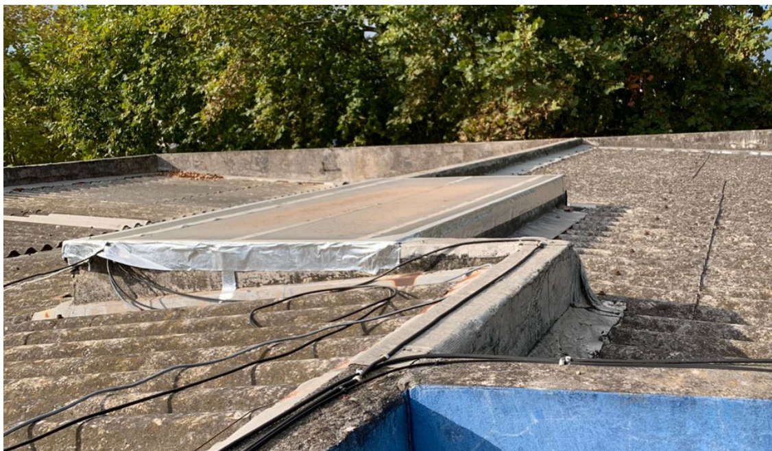
Imagem 2 - Claraboia a ser substituída
