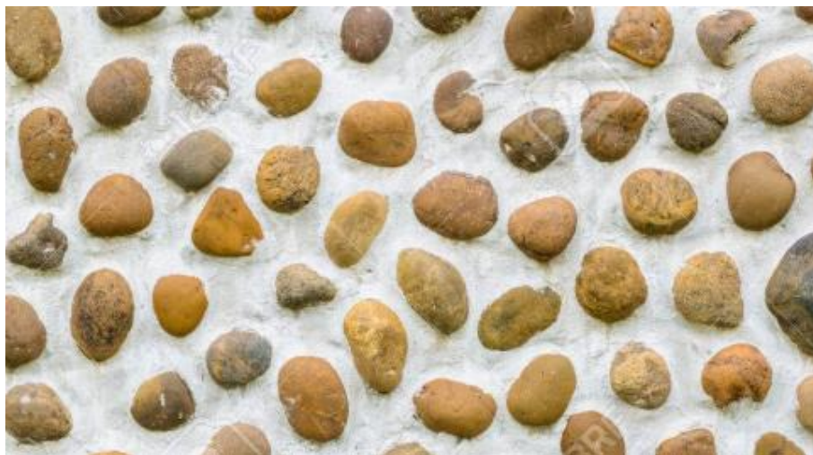
Figura 16 – Exemplo de piso sensorial com seixos rolados.
