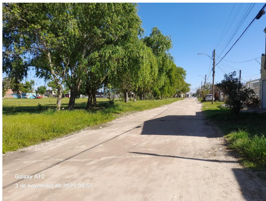
Figura 4 – Vista geral pela Rua Paraguai.
