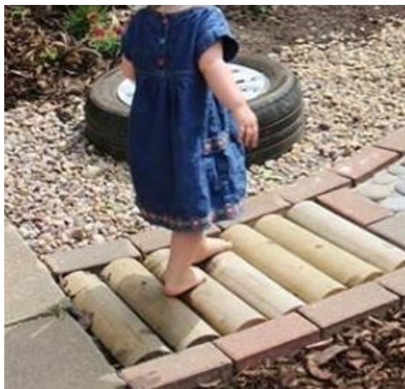
Figura 17 – Exemplo de piso sensorial com mourões de madeira roliça.
