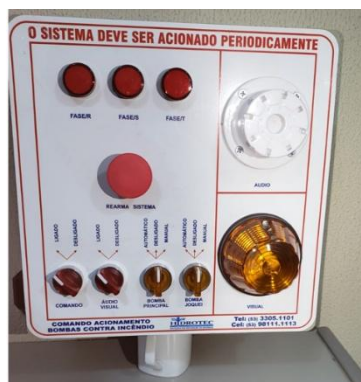
Figura 37 – Imagem referência – quadro comando bombas incêndio.
