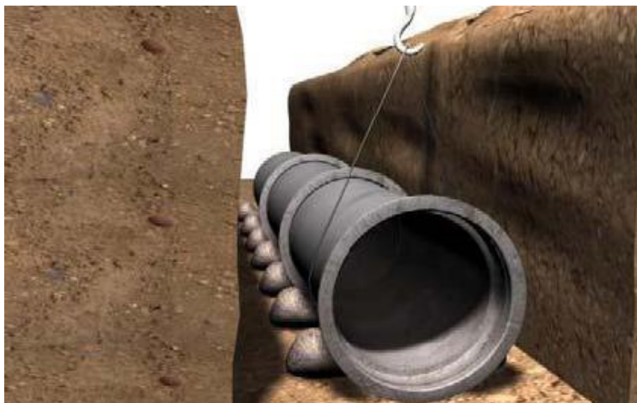
Figura 11 - Alinhamentos dos tubos com apoio de calços
