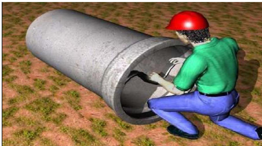
Figura 5 - Colocação do anel de borracha
