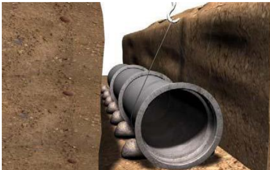
Figura 7 - Alinhamentos dos tubos com apoio de calços
