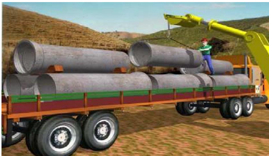
Figura 3 – Descarregamento das tubulações
