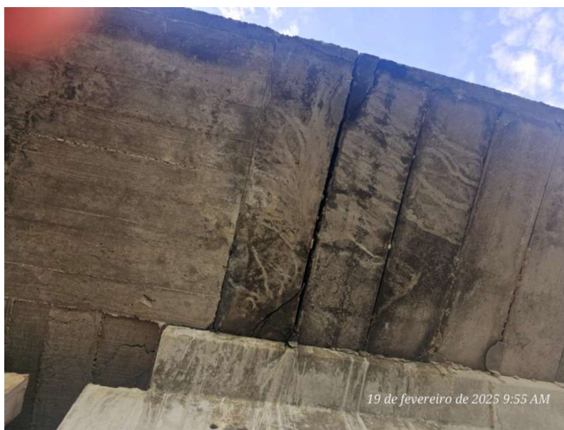
Figura 19- Imagem da Ponte 7
