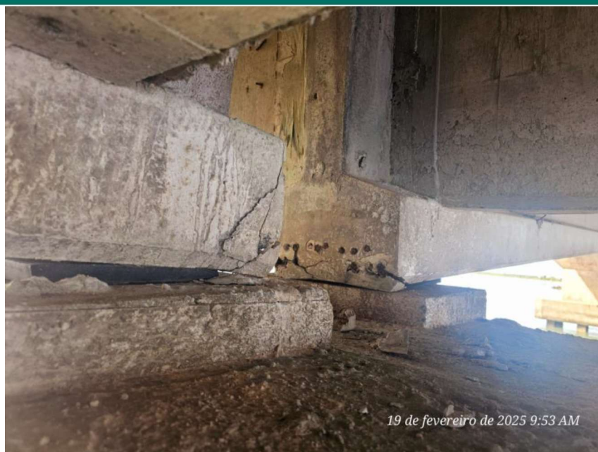
Figura 14 - Imagem da Ponte
