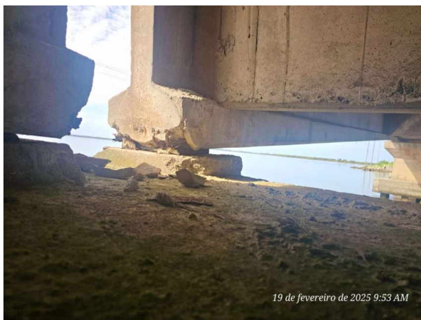
Figura 13 - Imagem da Ponte
