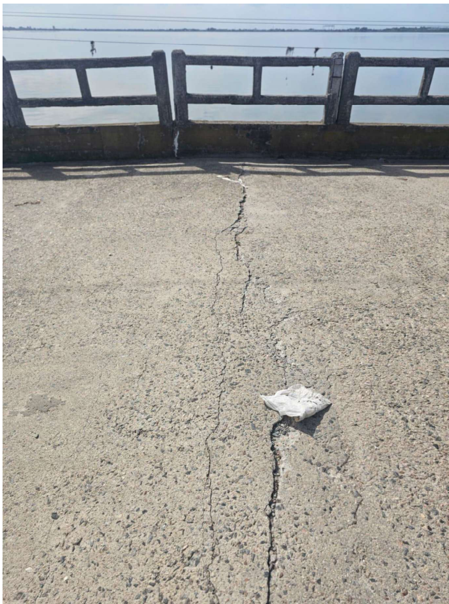
Figura 18 - Imagem da Guarda corpo deteriorado existente
