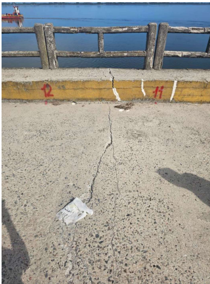
Figura 3 - Imagem da Ponte
