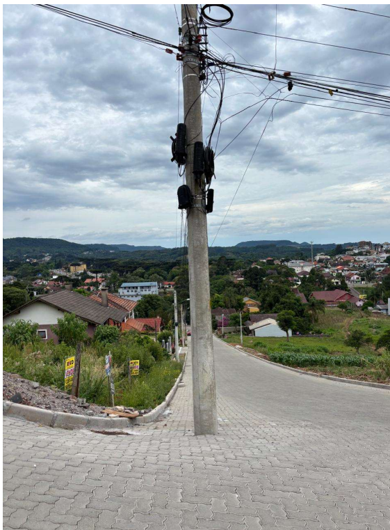
Foto 01 – Situação in loco do Poste 01
