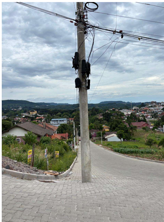
Foto 01 – Situação in loco do Poste 01
